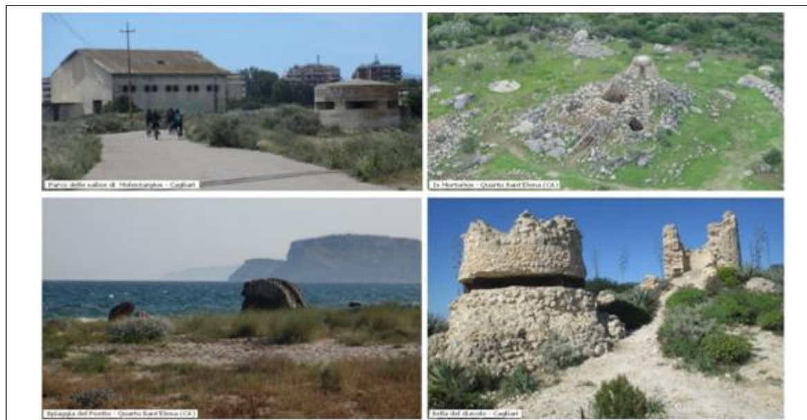
Fig.1 Bunker lungo il litorale di Cagliari e Quartu Sant'Elena (Sardegna Meridionale)
