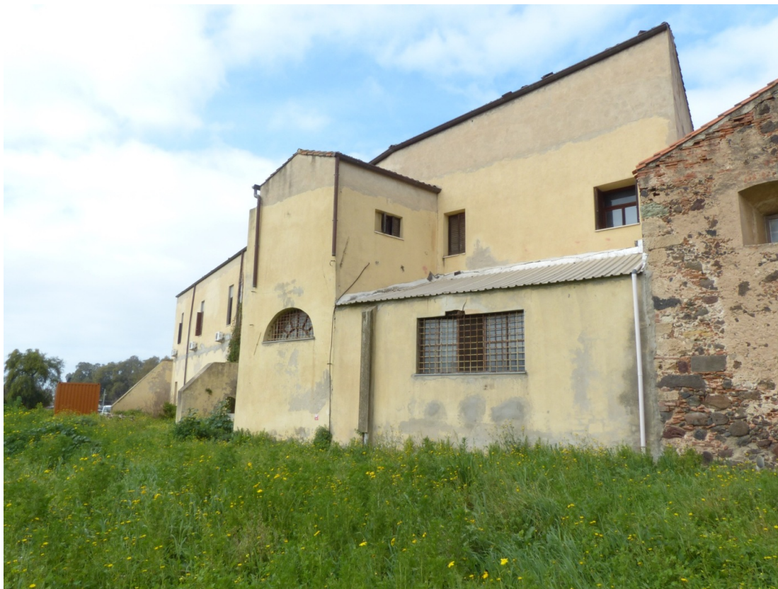
Figura 12: lato nord del convento
