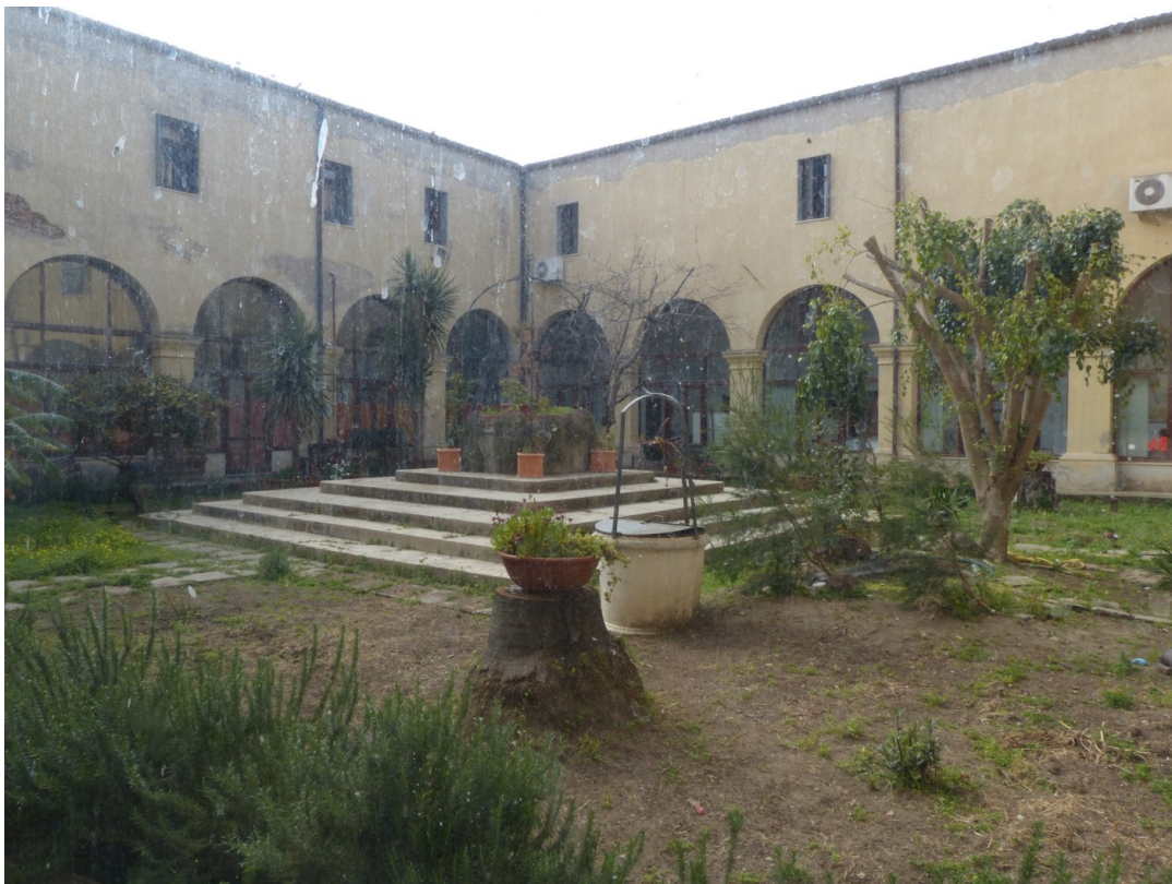
Figura 11: chiostro del convento
