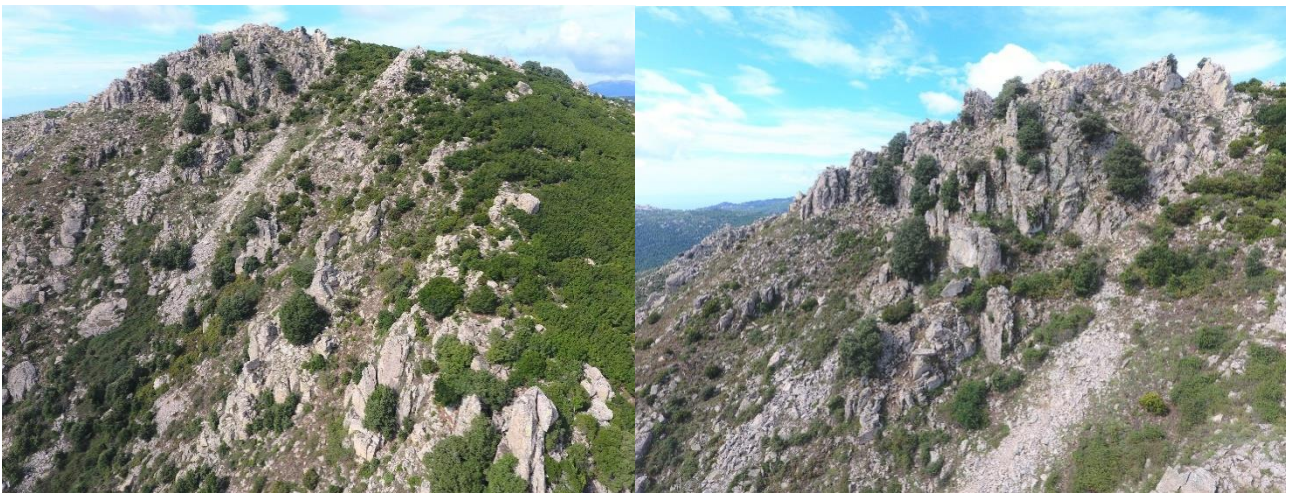
Figura 104 - Canale con scariche di detrito lungo il versante occidentale del bacino idrografico rappresenta uno dei fattori di instabilità e fonte di prima alimentazione delle colate rapide di debris flow.
