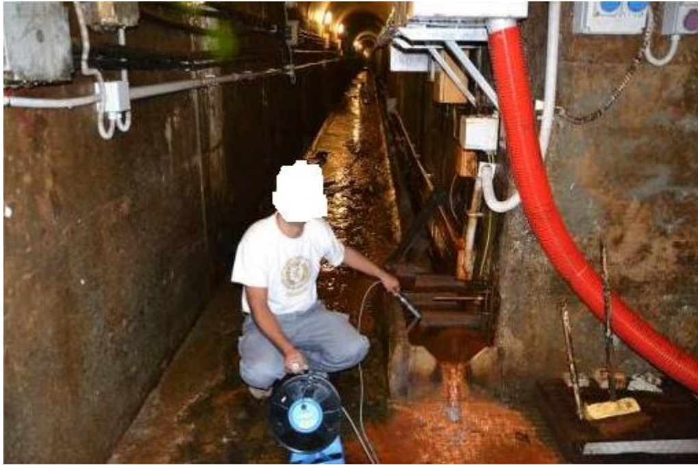
Fig. 9.2 – Cunicolo di controllo, in basso il dreno longitudinale sinistro in alto il dreno sinistro del manto con il relativo canale di raccolta.
