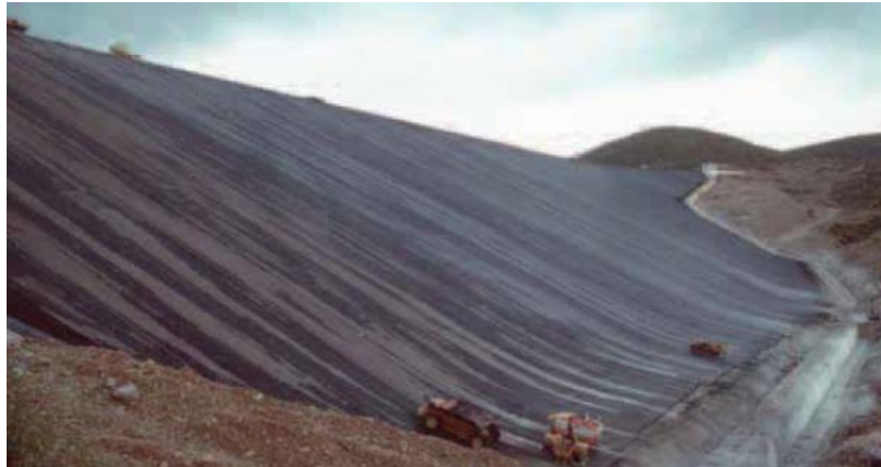
Fig. 13.4– Rivestimento interno del manto completato - anno 1987 (foto Impresa Sarti).
