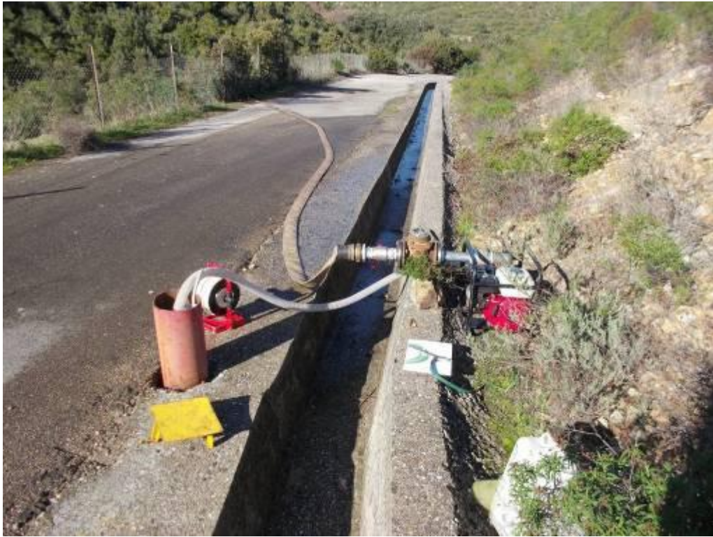
Fig. 11.2 –Esecuzione della prova di emungimento sul pozzo n°221, ubicato nel fianco sinistro.
