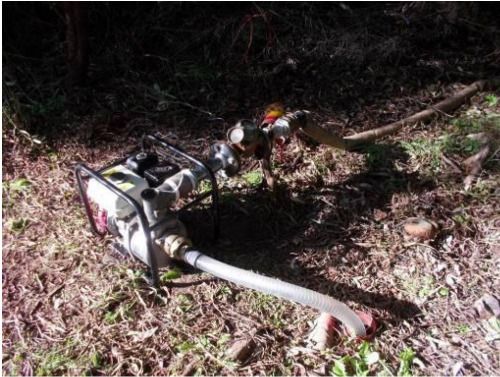
Fig. 11.9 – Esecuzione della prova di emungimento sul piezometro BH1001.
