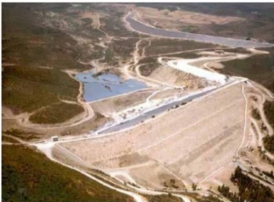
Fig. 7.3 – Vista della dell'argine di sbarramento di Medau Zirimilis a fine lavori nell'anno 1991.
