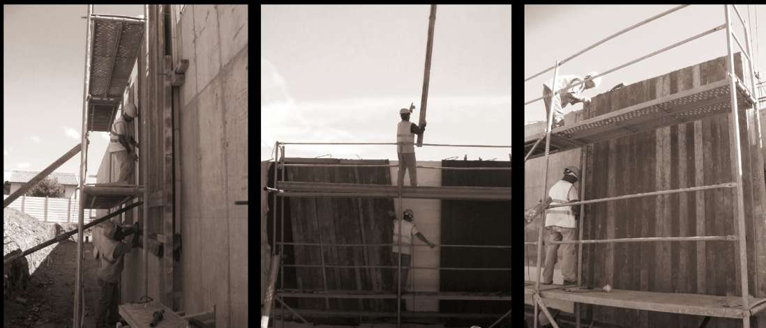
Foto delle varie fasi di fissaggio delle lastre di scisto al setto portante in calcestruzzo armato. Da sinistra verso destra si leggono le fasi per il posizionamento delle singole lastre, che presentano tutte sezione costante (8x11 cm) e altezza variabile, fino a oltre 5 m. Le lastre calate dall'alto attraverso l'utilizzo di una gru, vengono fissate singolarmente; è, inoltre, presente un sistema di fissaggio supplementare alla parete in calcestruzzo armato, ogni 4/5 unità. [F_A-S]
