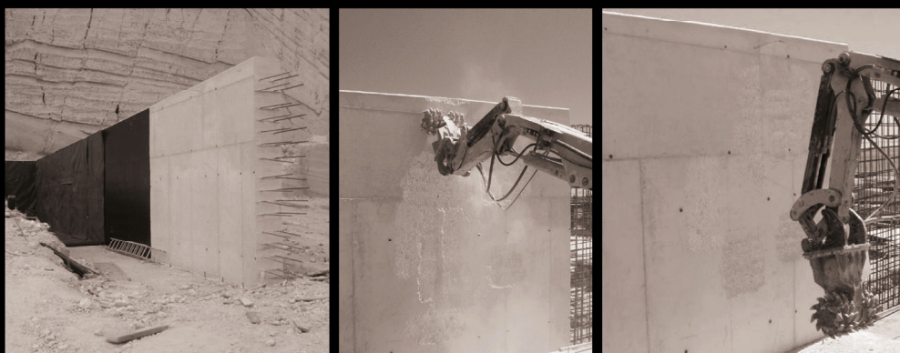
◀ ▲ Fasi di cantiere. Effettuazione del getto mediante utilizzo di casseforme standard, successiva impermeabilizzazione delle porzioni che rimarranno interrare e trattamento superficiale mediante fresatrice automatica delle parti a vista. [F_A-AU + peresabater]
