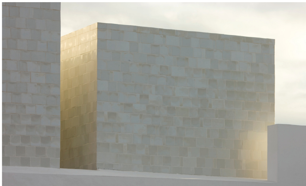
▲ Le superfici ceramiche alla luce del tramonto. [F_A-M]
