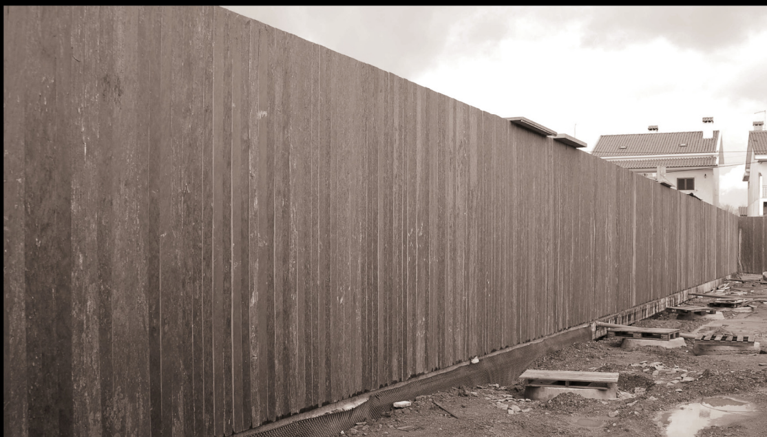
Tra loro le lastre sono distanziate di alcuni millimetri per permettere al materiale di dilatarsi liberamente nei casi di escursioni termiche. Il ritmo verticale dato dall'affiancamento delle lastre si perde nelle sfumature ferrigne dello scisto, tanto che a seconda dell'incidenza della luce, l'involucro murario ricorda lo stesso banco roccioso. [F_A-S]
