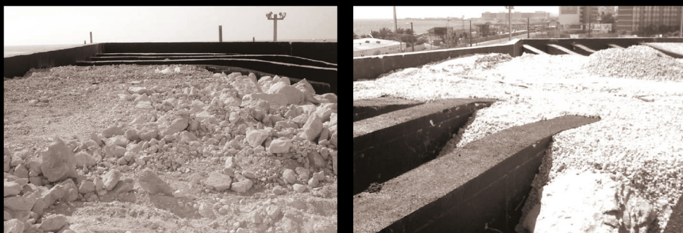
◀ ▲ Fasi di cantiere. Impermeabilizzazione e trattamento dei setti perpendicolari alla facciata principale, spianamento e distribuzione degli inerti e del materiale di scarto della cava. [peresabater]
