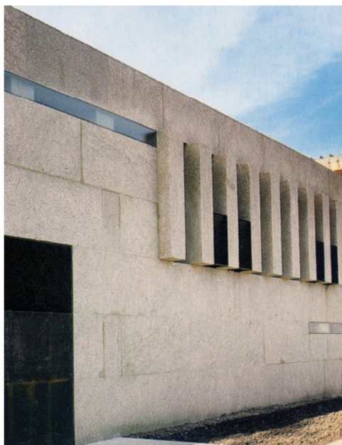
▲ Facciata e dettaglio delle cantine Les Aurelles, nel sud della Francia, realizzata in blocchi di pietra calcarea monolitici disposti orizzontalmente e posati a secco. [F_T-9]
