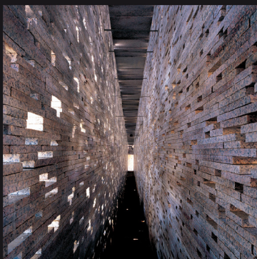
Recostrucción Muralla Nazarí A. Jiménez Torrecillas
