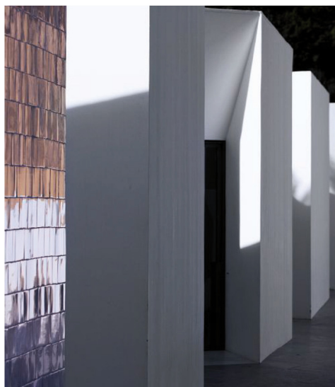
▲ Dettaglio delle pareti esterne: la superficie vibrante del rivestimento con azulejos bianchi nelle preesistenze e le pareti lisce e opache dei nuovi volumi. [F_A-M]
