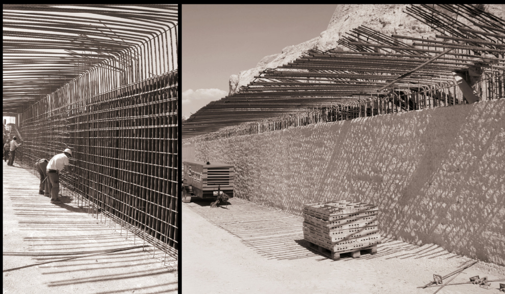
◀ ▲ Fasi di cantiere. Realizzazione delle armature dei setti principali di contenimento. Le operazioni di cantiere di armatura, getto e fresatura finale sono avvenute anche sincronicamente per alcuni setti murari. [F_A-AU]
