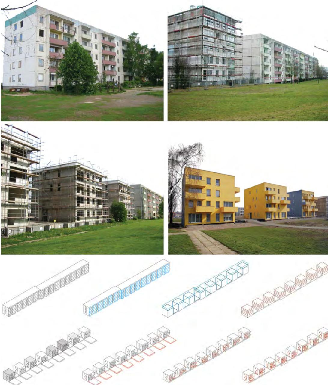
Figura 5 - Stefan Forster Architekten – Bestand / Abbruch balkone / Abbruch 5 OG und Zwischenfelder / Einbau Ringanker / Farbliche Individualisierung / Addition garten / Addition Balkone / Fassadengestaltung
