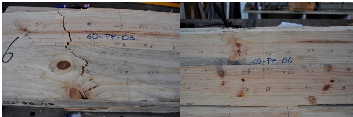
Figura 4.2.9 Rotture di pannelli omogenei di Pino Marittimo a 3 strati
