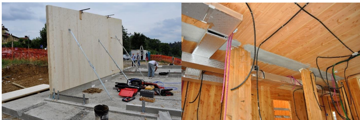
Figura 4.1.2 Utilizzo del xlam come elemento parete (sinistra) e solaio (destra)
