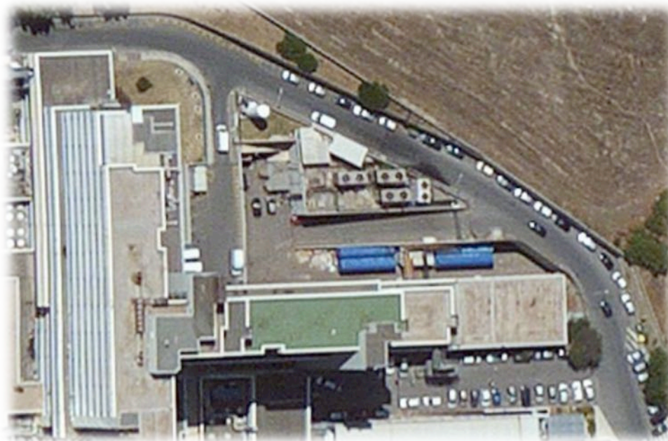
Figura 8 - Veduta aerea dell'area Sud-Ovest sede delle varie centrali tecnologiche
