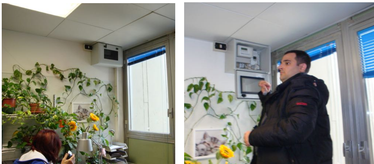
Figura 5 – Immagini dell'ubicazione del data-logger e della modalità di accesso per la lettura dei dati.
