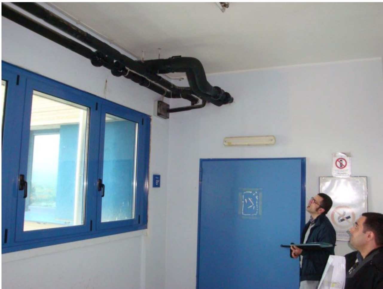
Figura 6 - Immagini dei misuratori di portata e della scatola contenete i misuratori di energia termica.
