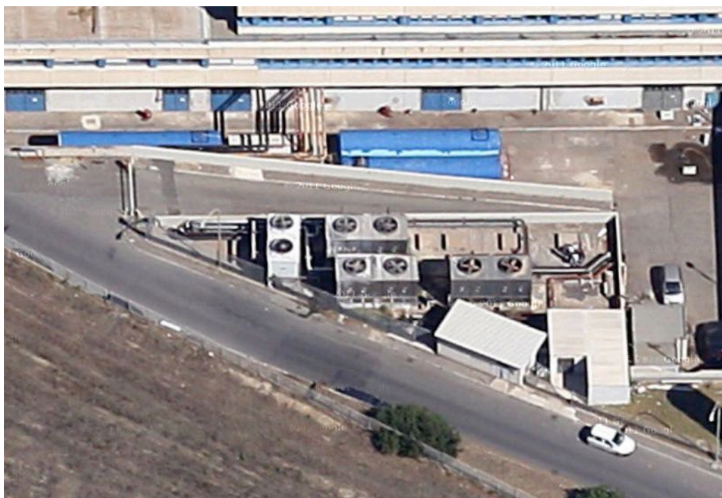
Figura 19 - Vista aerea delle torri evaporative nell'area delle centrali tecnologiche dell'A.O.B.
