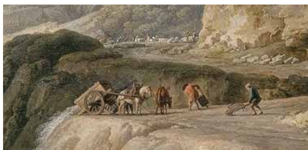
Sversamento di rifiuti nel fiume, secondo una pratica di cantiere all'epoca ampiamente utilizzata.
