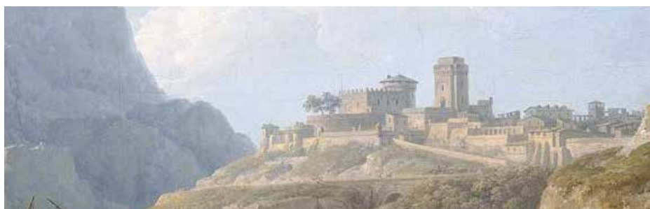
Dettaglio della cittadella fortificata verso cui probabilmente si dirige la nuova strada in costruzione.
