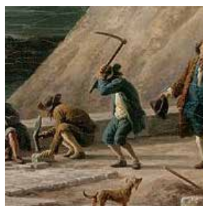
Preparazione del fondo stradale
