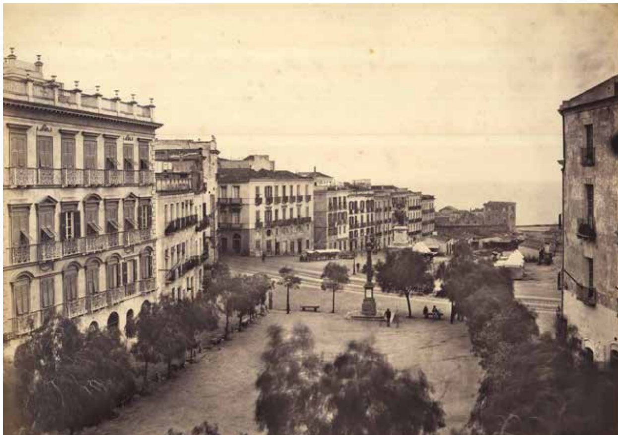
Piazza San Carlo vista da nord, 1870 (ASCCa, Fondo Fotografico, s. IX, 491). La foto ritrae l'attuale Piazza Yenne (ex Piazza San Carlo), l'imbocco della Via Manno sulla sinistra e il Largo Carlo Felice ancora occupato da una serie di basse costruzioni.
