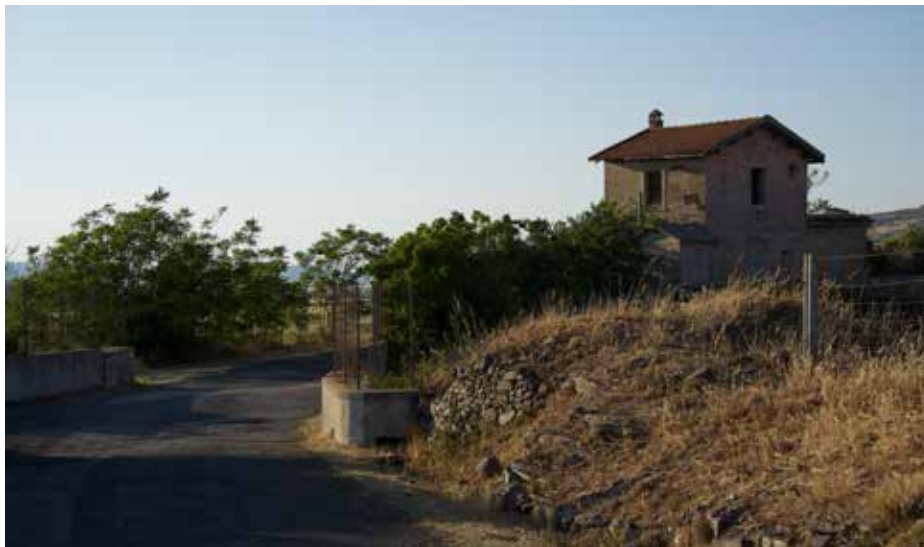
Casa cantoniera nei pressi del vecchio tracciato della Strada Reale Carlo Felice tra Bonorva e Giave (foto Stefano Mais).
