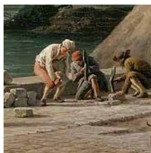
Operai impegnati nella posa delle pietre.
