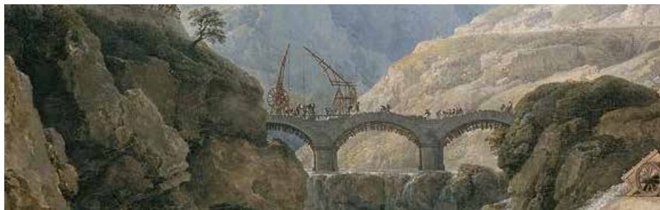
Dettaglio della costruzione del ponte, costruito con pietra da taglio. Si notano le centine in legno nei tre archi e alcuni macchinari con ruote calcatorie per il sollevamento dei materiali da costruzione. I ponti sono le «opere d'arte» più complesse di un infrastruttura stradale, ampiamente ritratti dall'iconografia di paesaggio prodotta tra Settecento e Ottocento.
