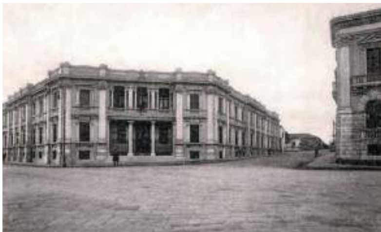
Fig. 3. Giuseppe Cobolli Gigli, l'edificio della Banca d'Italia di Messina (1924), in una cartolina di poco successiva alla sua costruzione.
