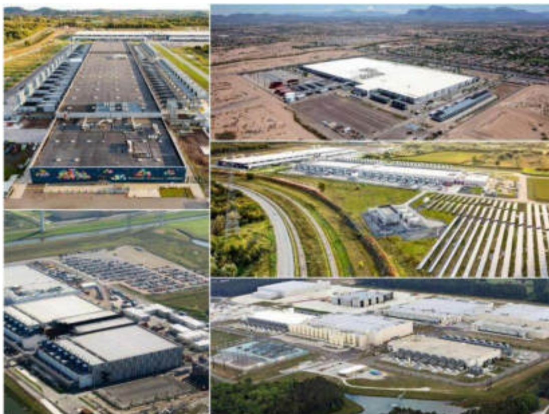
Figura 2 | Foto-composizione di alcuni tra i data center proprietà delle più famose software-house . Fonte: datacenterdynamics.com del maggio 2022
