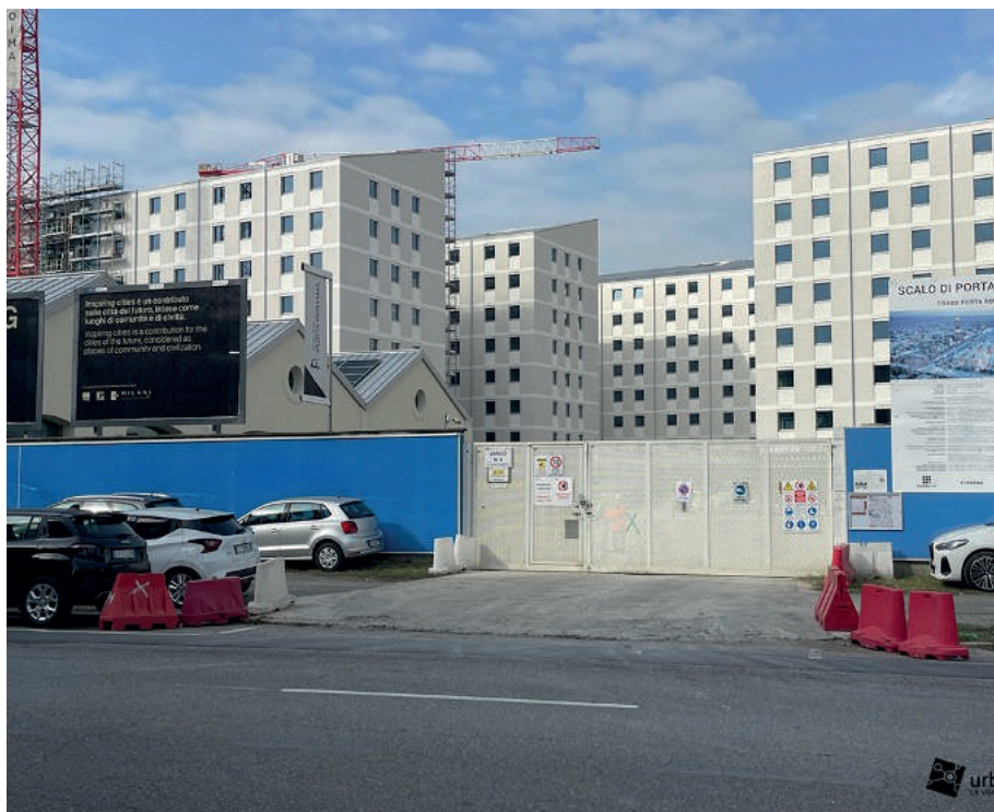
Fig. 7: Cantiere del Villaggio Olimpico ( https://blog.urbanfile.org , 2024)
