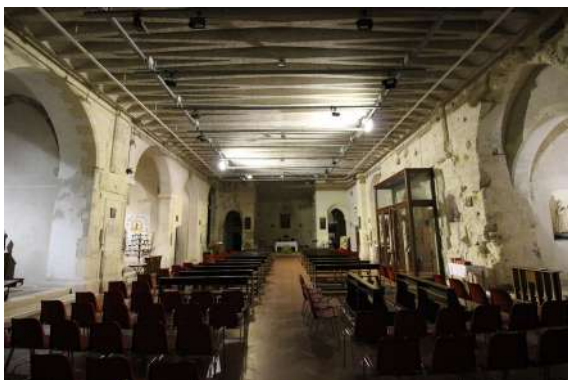
5: Cagliari, Cripta di San Domenico, foto dell'interno, che ingloba parte delle preesistenze. Sono evidenti le coperture in cemento armato che sostengono la chiesa soprastante, costruita dall'architetto Raffaele Fagnoni tra il 1952 e il 1954 (foto Claudio Nonne).
