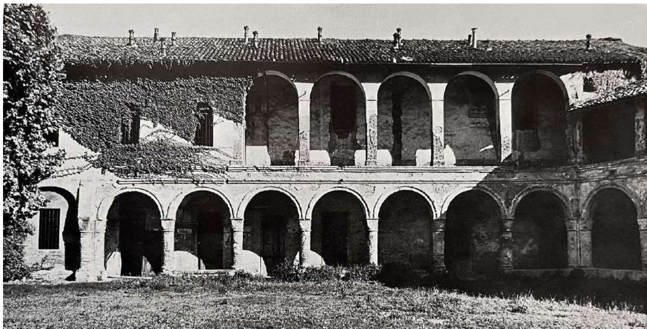
6: Vista del chiostro della caserma di Santa Chiara, 1973 (© Giuliano Regis).
