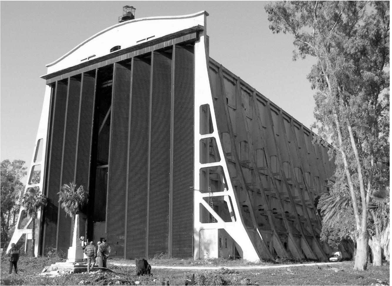
4. Augusta, Hangar, prospetto principale.
