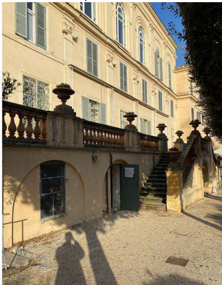
6: Bruno Zevi, Villa Aurelia nel 2022, il fronte sud liberato dalle superfetazioni con il restauro di Zevi. Negli ipogei permane la forma trapezoidale delle bay-windows (foto dell'autore).
