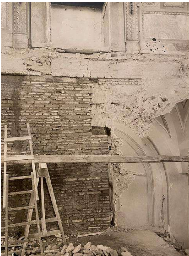
3: Bruno Zevi, Villa Aurelia, rilievo fotografico delle fasi di restauro con la messa a nudo della possibile porzione di mura aureliane sul fronte sud, 1948, American Academy in Rome, Rare Books Room, Arthur and Janet C. Ross Library.
