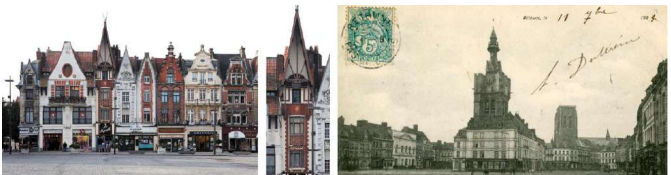
3: La Grand'Place di Bethune ridisegnata da J. Alleman e dettaglio della Maison du Grain ; a destra, la stessa prima delle devastazioni belliche, in uno stile architettonico significativamente diverso [Archives départementales du Pas de Calais].
