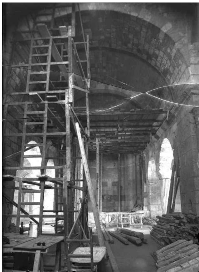
2: Cagliari, Basilica di San Saturnino, interno durante i lavori di restauro successivi al bombardamento del 1943 (Su concessione della Soprintendenza Abap per la città metropolitana di Cagliari e le province di Oristano e Sud Sardegna).
