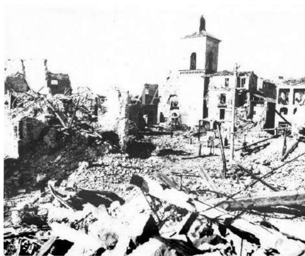
7: Piazza Orsini dopo il bombardato del 1943, con gli edifici bislungi danneggiati, prima della demolizione.
