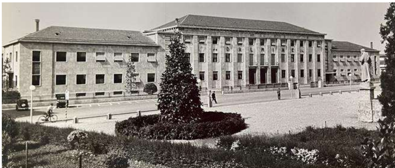
3: Il nuovo palazzo della Direzione e Amministrazione alla fine degli anni Trenta del Novecento. © Fondazione Dalmine.
