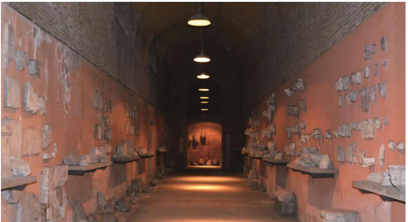
3: Stato di fatto della galleria 'dei reperti marmorei'.
