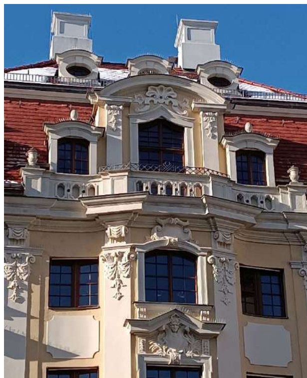
10-12: Elementi decorativi identici agli originali, ma generalmente prefabbricati in calcestruzzo.
