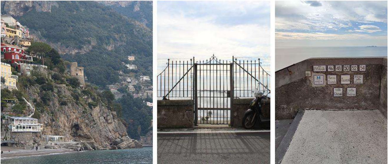
3: Da sinistra verso destra: Torre Sponda dalla spiaggia Grande; accessi alla Torre da via Cristoforo Colombo [L. Del Giudice 2023].
