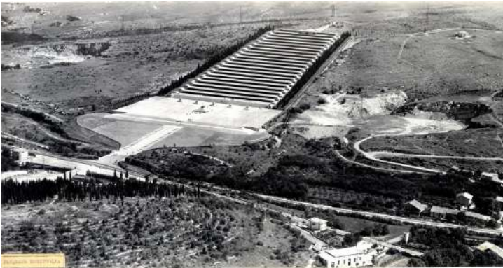
5: Il complesso dopo l'ultimazione.
