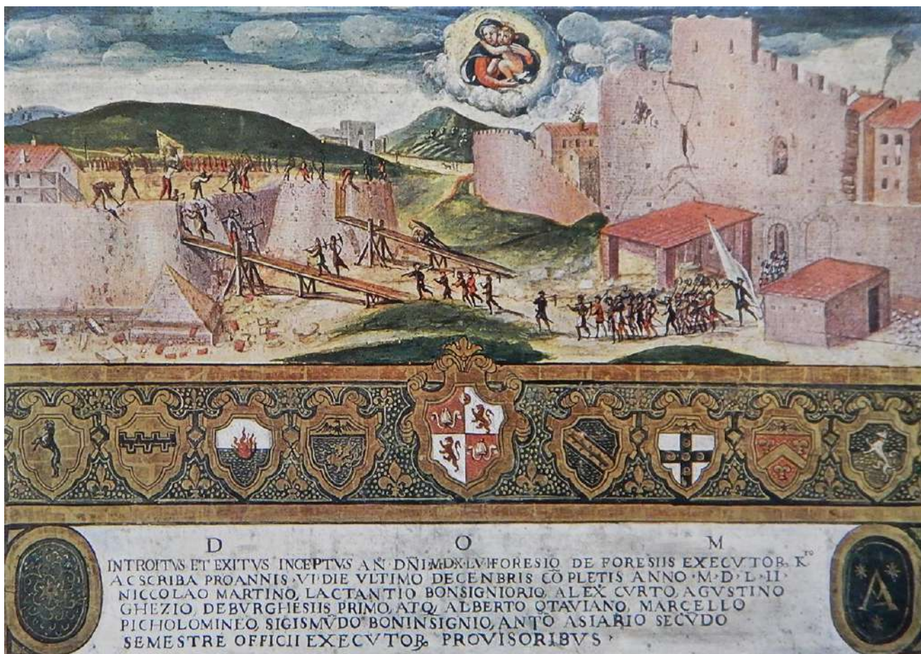
2: La demolizione della fortezza spagnola, 1552 [Siena, Archivio di Stato, Biccherne, 58. Da Le Biccherne senesi 1964, 147].
