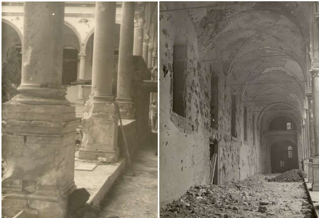
1-2: Danni al chiostro di marmo dell'ex monastero dei Santi Severino e Sossio, sede dell'Archivio di Stato di Napoli, causati dall'incursione aerea del 9 novembre 1941 (ASNa, Segretariato nuovo, III serie, b. 38).
