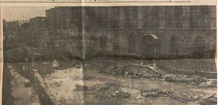
La storica chiesa, mentre si libera dalle tarde costruzioni, già mostra l'imponenza delle sue strutture trecentesche
