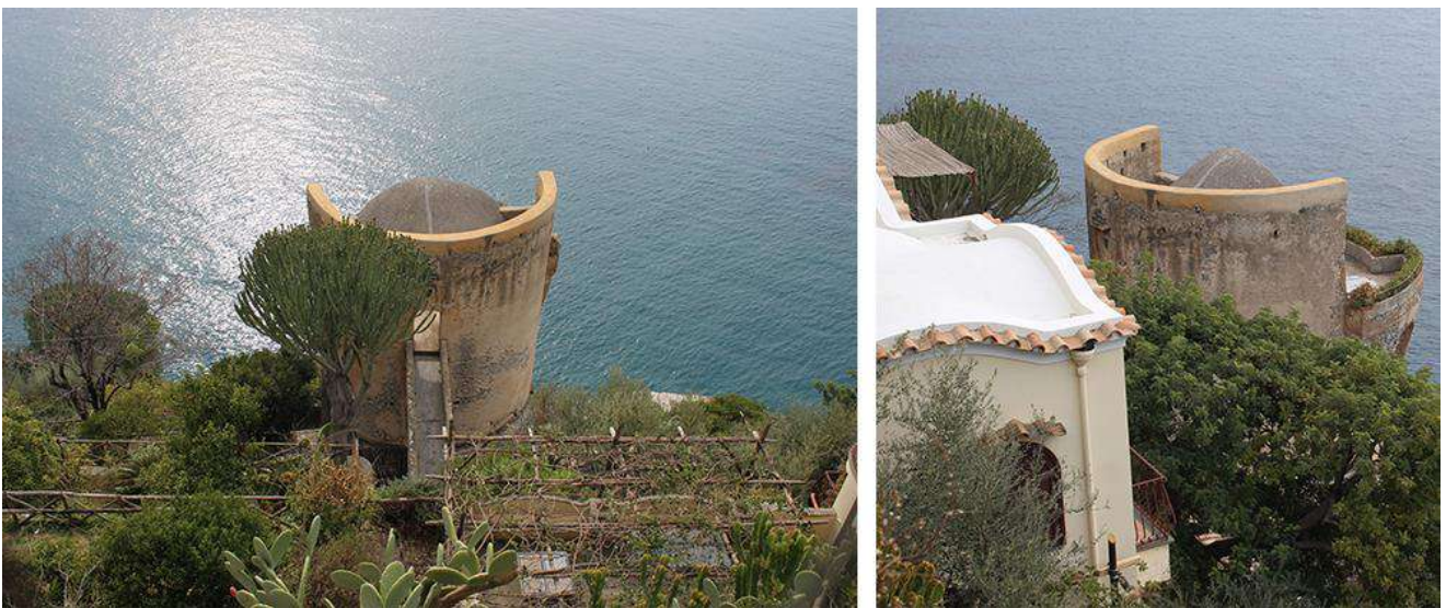
4: Torre Sponda da Via Cristoforo Colombo [L. Del Giudice 2023].
