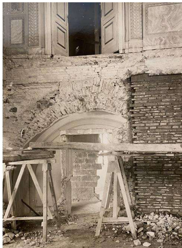
4: Bruno Zevi, Villa Aurelia, rilievo fotografico delle fasi di restauro con la messa a nudo della possibile porzione di mura aureliane sul fronte sud, 1948, American Academy in Rome, Rare Books Room, Arthur and Janet C. Ross Library.
