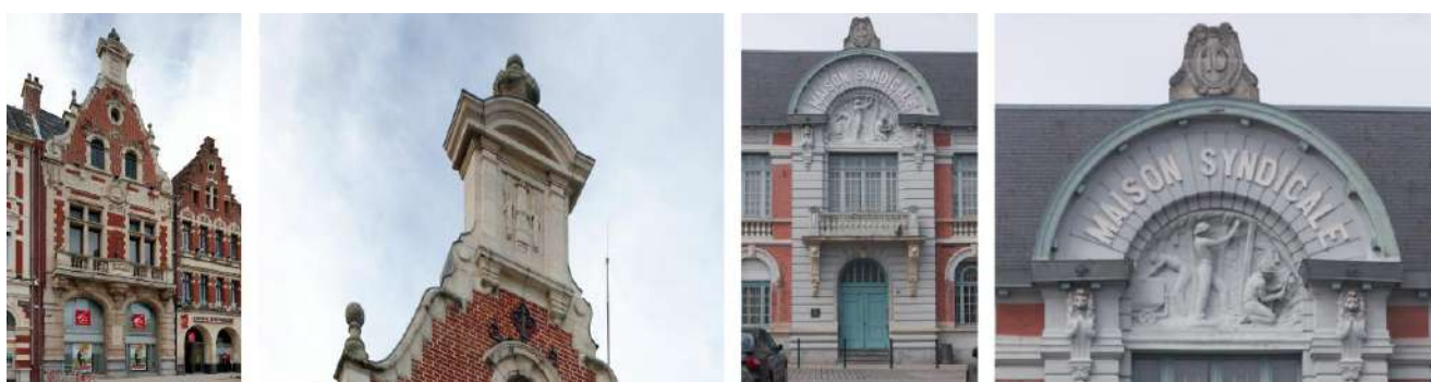
5: Due città dal passato minerario: Caisse d'Épargne a Bethune, lampada da minatore sull'edificio [Archives départementales du Pas de Calais]; Maison Syndicale des Mineurs a Lens, altorilievo [S. Guadagno 2018].
