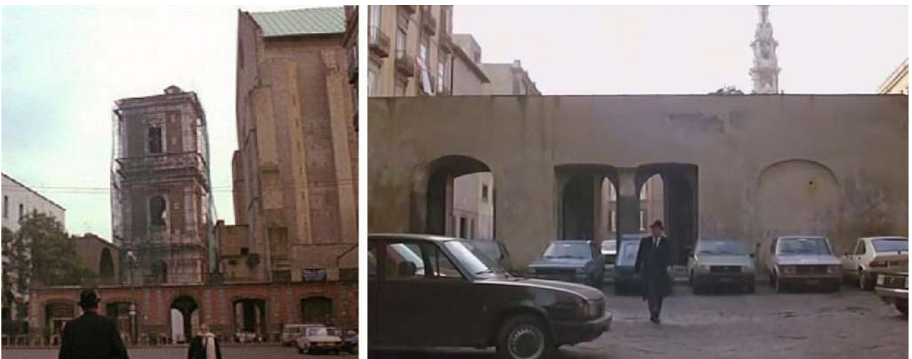
3, 4: I due fronti dell'edificio situato tra Piazza del Gesù Nuovo ed il sagrato della chiesa di Santa Chiara dopo i lavori di sistemazione diretti da Roberto Pane e Roberto di Stefano, immortalati nelle scene del film Maccheroni (1985) con Jack Lemmon in primo piano.
