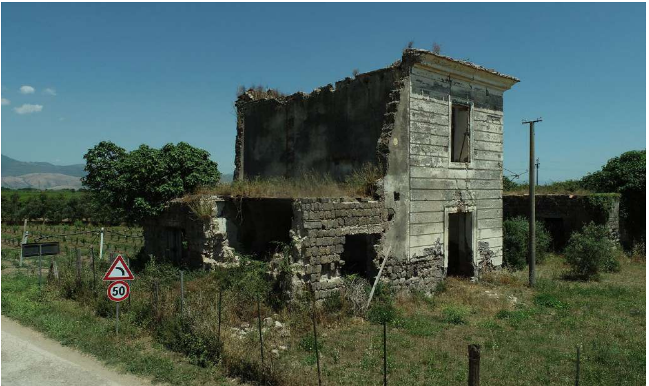
3: Una vista da cui si può vedere la lacuna provocata dai bombardamenti del 1943 all'edificio centrale del Demanio di Calvi e la cappella superstite (foto dell'autrice).
