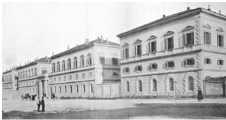
4: Roma, Ospedale Militare Celio, prospetto principale su via Celimontana (Traniello 1901).
