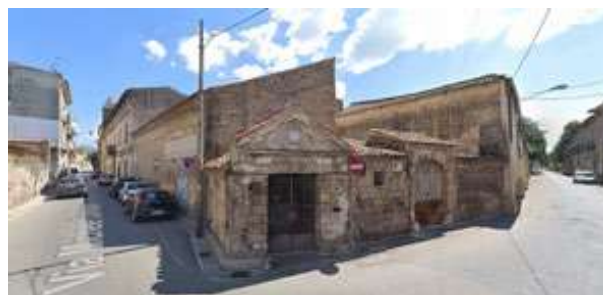
7: Confine del parco reale lungo via Passionisti: ingressi da Ercole.
