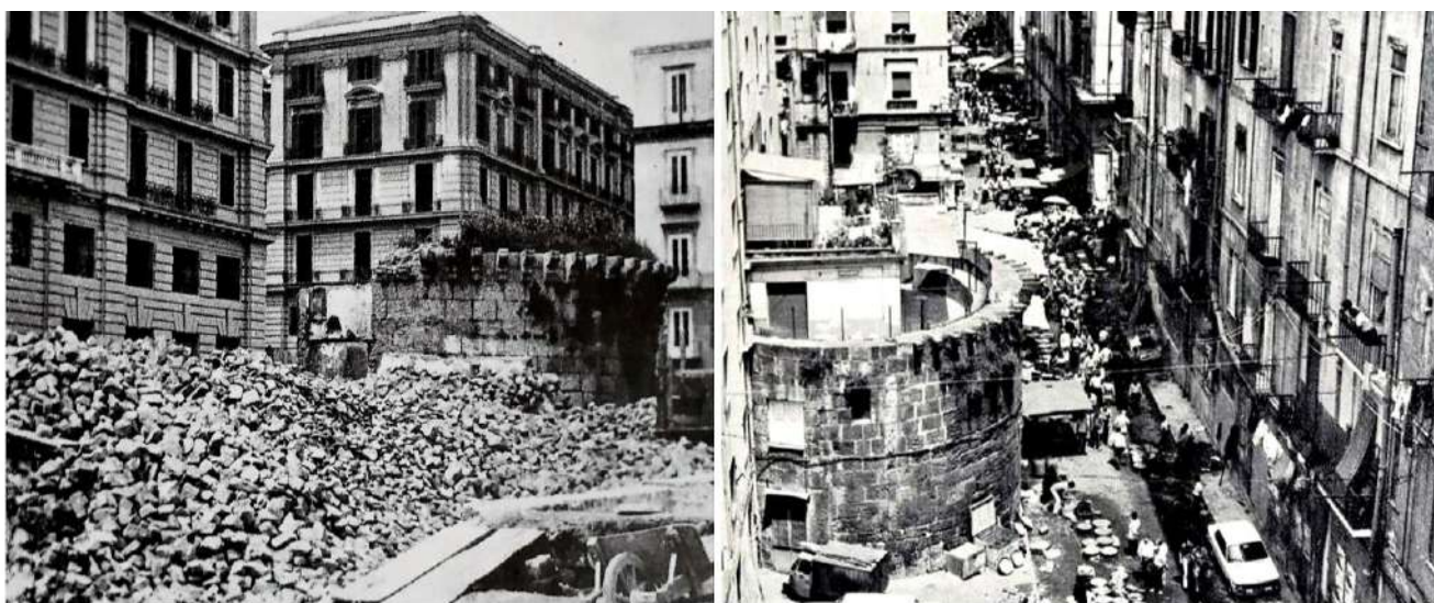
2: La demolizione della Torre San Severo in piazza Garibaldi, a sinistra; la Torre Fedelissima, a ridosso di via Soprammuro nei pressi di Porta Nolana, a destra, collezione privata.
