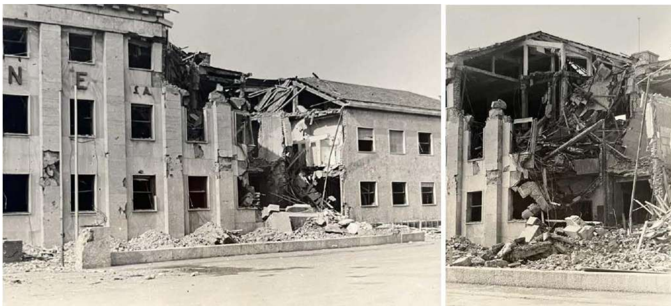
4: Effetti del bombardamento sull'edificio della Direzione. Crollarono due campate all'estremità del corpo centrale, il vano scala di destra e due campate del corpo laterale destro. © Fondazione Dalmine.
