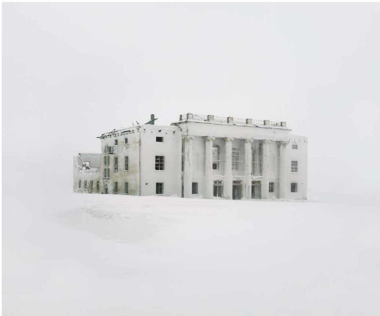
2: Casa della Cultura, insediamento minerario Khalmer-Yu (oggi proving ground "Pemboy"), Repubblica dei Komi, Russia [© Danila Tkachenko].
