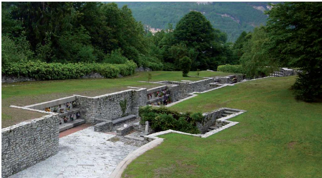
5: Cimitero di Longarone (foto e disegni dell'autore): la lunga spezzata che definisce l'impianto longitudinale della trincea sepolcrale offre una spazialità in divenire.
