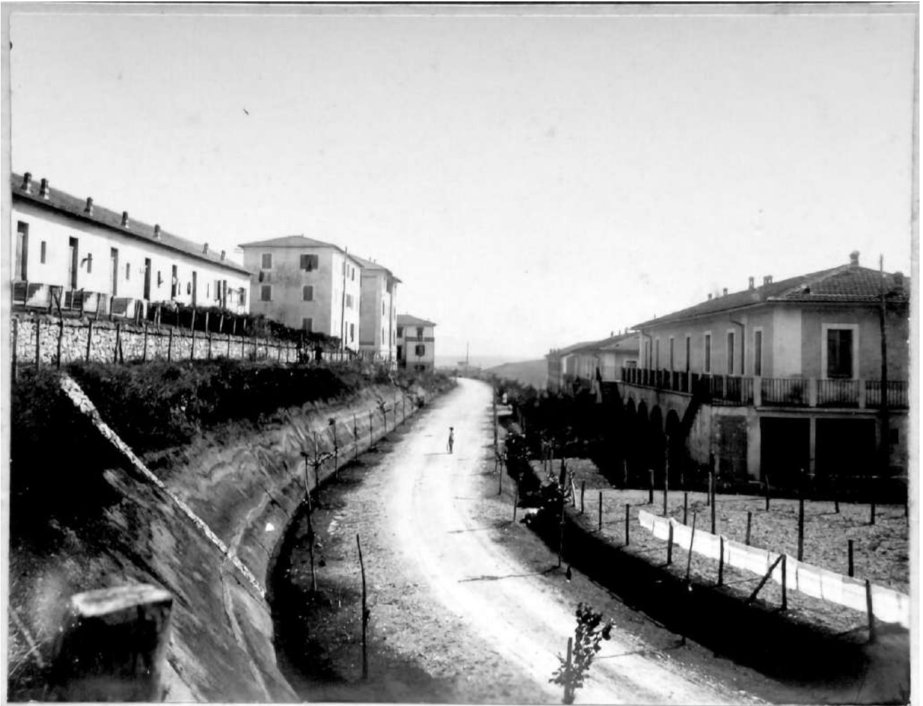
1: Case a ballatoio per operai, case 5-6-7-8, fotografia d'epoca, Colleferro. Archivio multimediale Città morandiana (tesi di laurea di Bianca Coggi).
