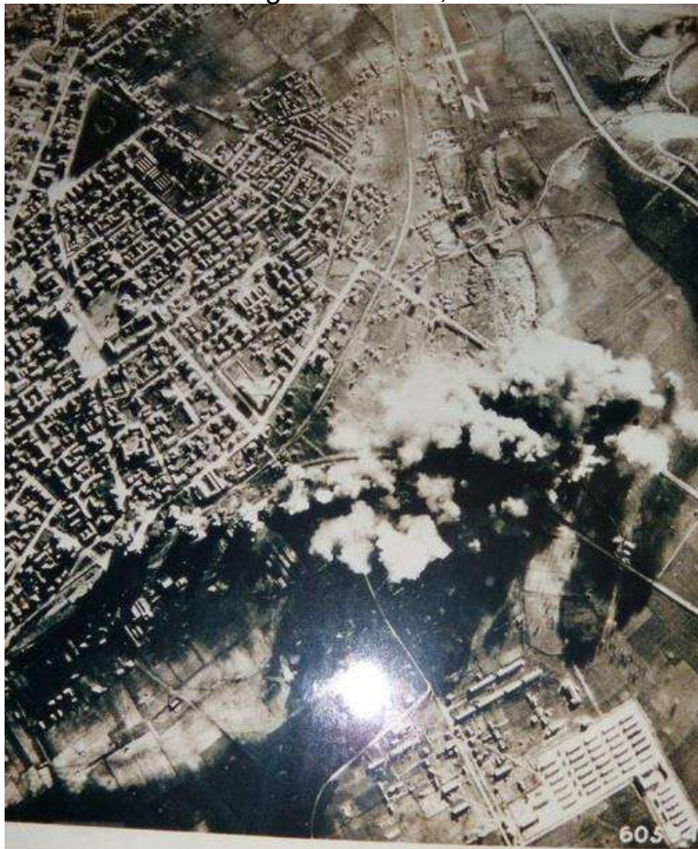
1. Bombardamenti eseguiti dai North American B-25 Mitchells del Twelfth Air Force Walk the tracks sugli scali ferroviari di Avezzano (AQ), a est di Roma, il giorno prima dello sbarco alleato del 22 gennaio 1944.
