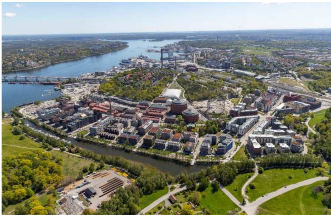
Figura 2 | | Dalla foto aerea, che pone in risalto il nuovo quartiere e le officine del gas funzionalizzate, si apprezza la relazione dell'intera area del Royal Seaport con il doppio abbraccio delle infrastrutture verde e blu: da un lato il parco, che la circonda e penetra all'interno dei quartieri verdi preesistenti, e dall'altro il mare, che la avvolge sull'altro lato e si inserisce con una stretta insenatura a mediare tra il nuovo quartiere e la parte più estesa del parco, in primo piano.
