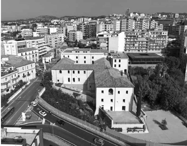
Catanzaro, ex Ospedale militare, veduta del complesso dopo l'intervento di rifunzionalizzazione. In primo piano il corpo di fabbrica storico e, in secondo piano, la 'corte contemporanea' (foto Studio F64 da Corvino+Multari).
