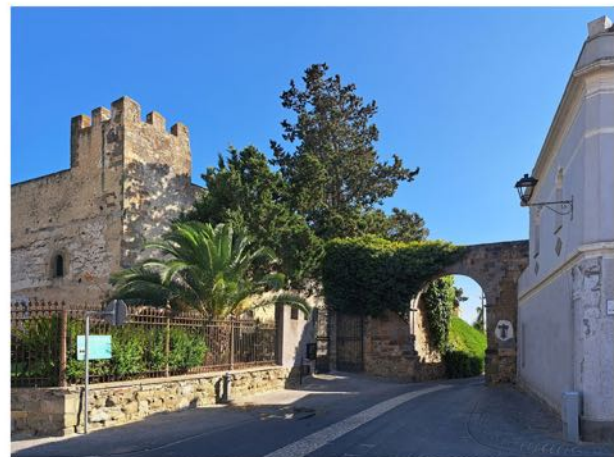
[8] CASTELLO DI SANLURI, ARCO DI ACCESSO ALLA CINTA MURARIA (FOTO STEFANO MAIS).
