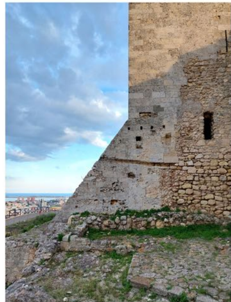
[6] CASTELLO DI SAN MICHELE A CAGLIARI. DETTAGLIO DELLA MURATURA A SCARPA AGGIUNTA AL PRECEDENTE VOLUME DI TORRE, LAVORATA IN BUGNATO SUI LATI ESTERNI (FOTO MARCO CADINU).
