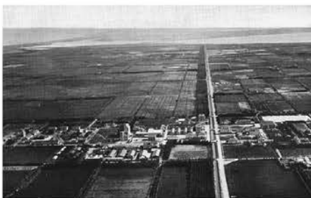
[15] LA BONIFICA DI ARBOREA, 1928/1935.
