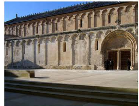
[10] PLANIMETRIA E VEDUTA DELLA BASILICA DI SAN GAVINO A PORTO TORRES NEL PROGETTO DI RECUPERO DI COLOMBARI DE BONI ARCHITETTI (2002/2008).
