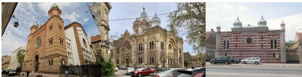
Figura 2. Le tre sinagoghe principali di Timișoara («Cetate» a sinistra, «Fabric» al centro e «Iosefin» a destra). Fonte: autore.
