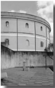
Fig. 4 - Elementi tipologici e spaziali distintivi delle strutture carcerarie, riferiti alle fabbriche storiche dismesse presenti sul territorio sardo (elaborazione F. Musanti).
