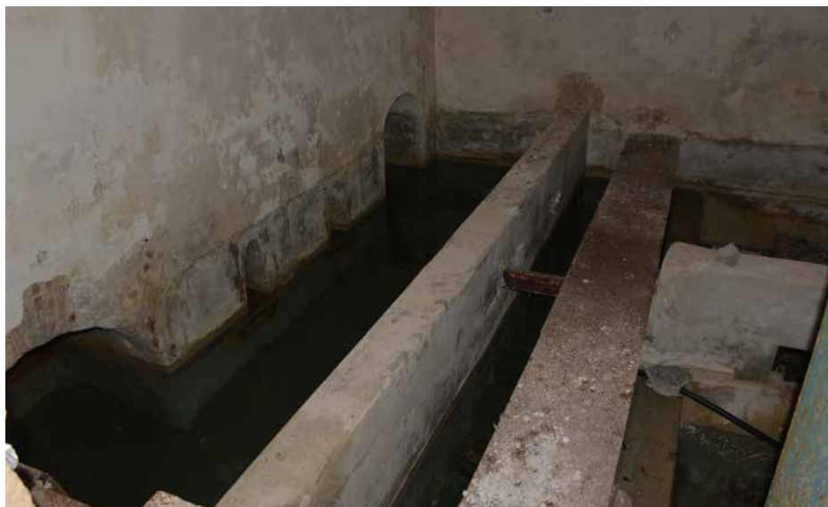
13. L'interno della cabina di sorgente di Cabu Abbas, edificio in pietra e mattoni degno di una piena riqualificazione e di annessione al patrimonio culturale della città (foto di Marco Cadinu).
