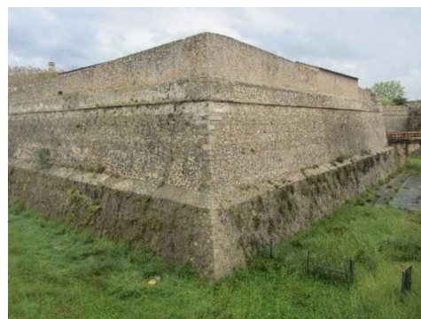
Fig. 21- Profilo gradonato nel mezzo bastione di Sainte-Barbe ad Ajaccio (fotografia di Andrea Pirinu, 2022)
