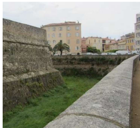
Fig. 22- Profilo gradonato nel mezzo bastione di Sainte-Barbe. Recenti indagini archeologiche hanno accertato una quota del fosso in origine più bassa di quella attuale (fotografia di Andrea Pirinu, 2022)
