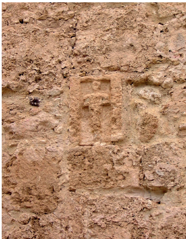
Fig. 3. NORA – Chiesa di Sant’Efisio. Esterno, prospetto meridionale, stele reimpiegata (foto A. Pala).
