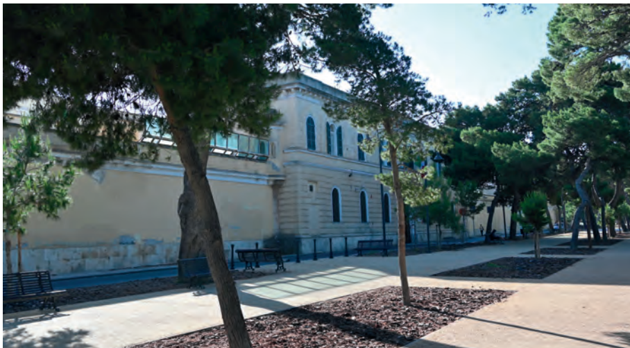
Fig. 3 - Fronte principale dell'ex Carcere di Buoncammino rivolto all'omonimo viale. L'elegante strada panoramica è stata tracciata negli anni '40 dell'Ottocento, in concomitanza con la costruzione della Caserma Carlo Alberto, su progetto di Domenico Carlo Barabino, situata a breve distanza dal penitenziario.
