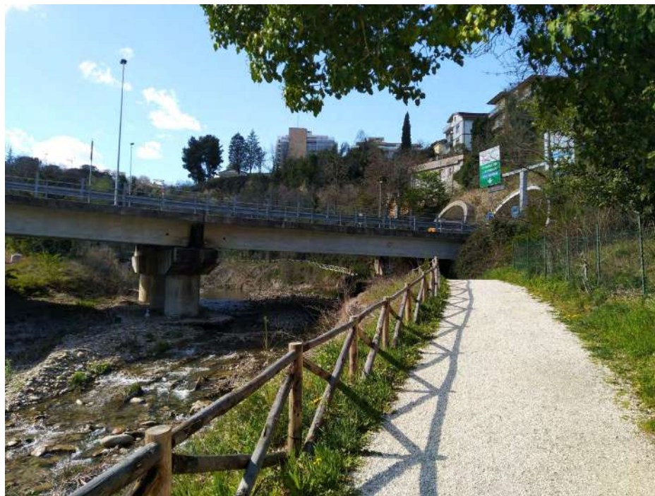
Fig. 1 - Lungofiume Tordino. Uno degli attraversamenti da parte della SS 80 “lotto zero” del fiume e della pista ciclo-pedonale
