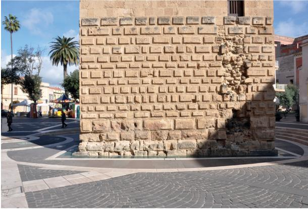
Fig. 4. ORISTANO – Torre di Mariano II. Prospetto laterale del basamento bugnato (foto F. Deriu).
