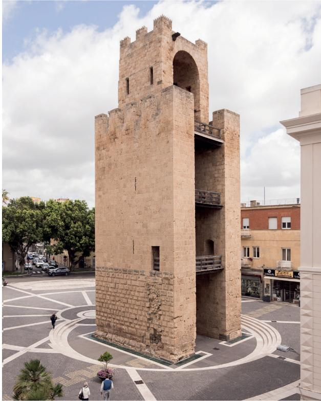
Fig. 2. ORISTANO – Torre di Mariano II. Veduta generale dal lato interno con in evidenza il primo terzo in altezza distinto dal basamento bugnato (foto S. Ferrando).
