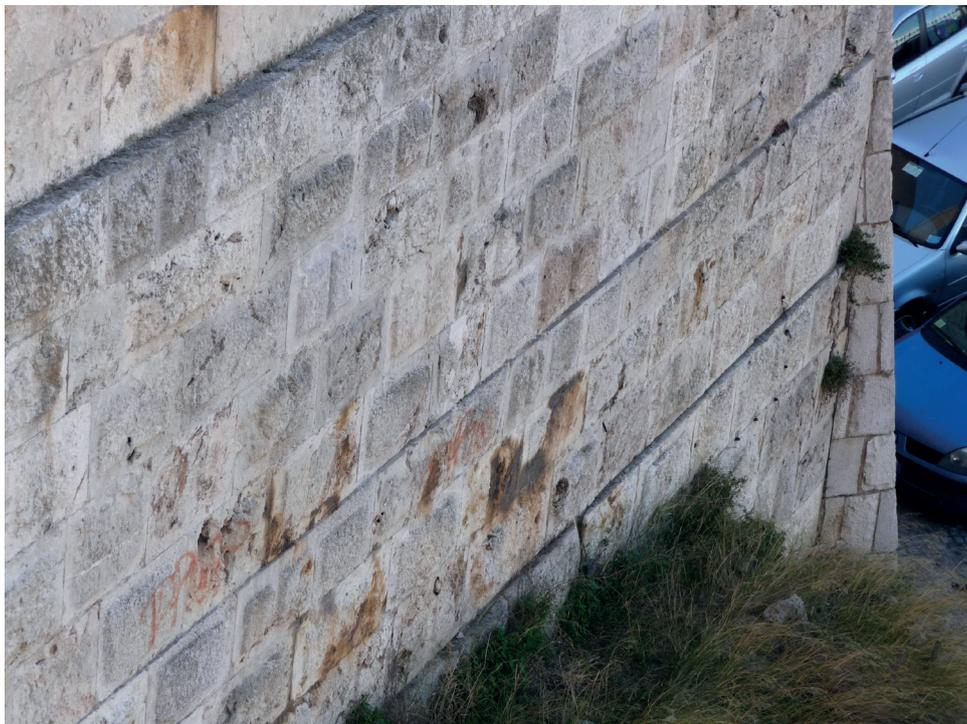
Fig. 6. CAGLIARI – Torre dell’Elefante. Bugnato del basamento, di conci isodomi con lavorazione (foto M. Cadinu).
