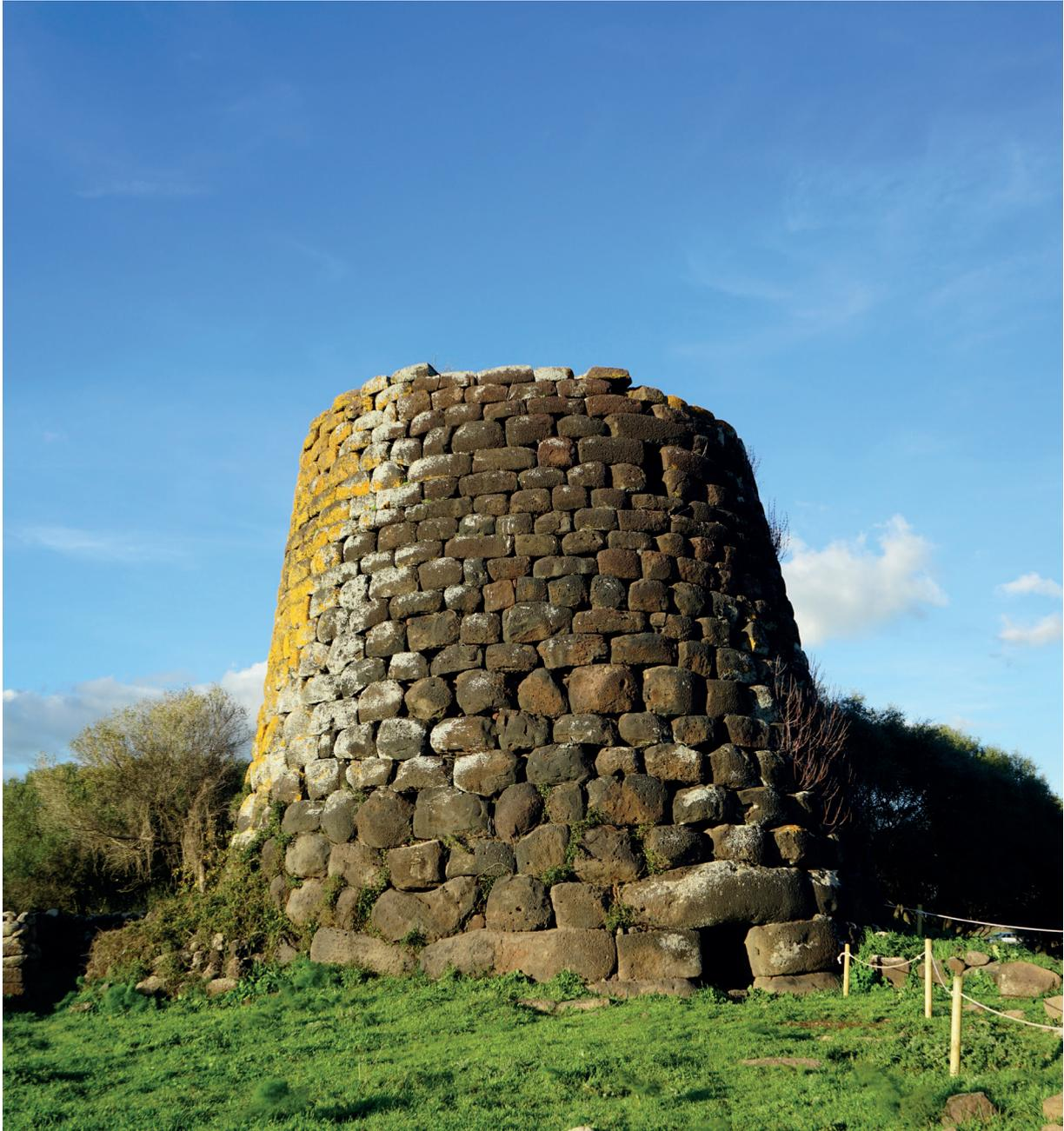
Fig. 1. DUALCHI – Nuraghe Pontes. L'architettura delle torri nuragiche frequentemente è impostata su di un basamento costituito da conci di dimensioni straordinarie su cui si impostano le serie dei filari dimensionati con regolarità e solo lievemente degradanti. Il nuraghe Pontes di Dualchi, di concezione unitaria, ha l'architrave lungo 3,65 metri (foto S. Mais).
