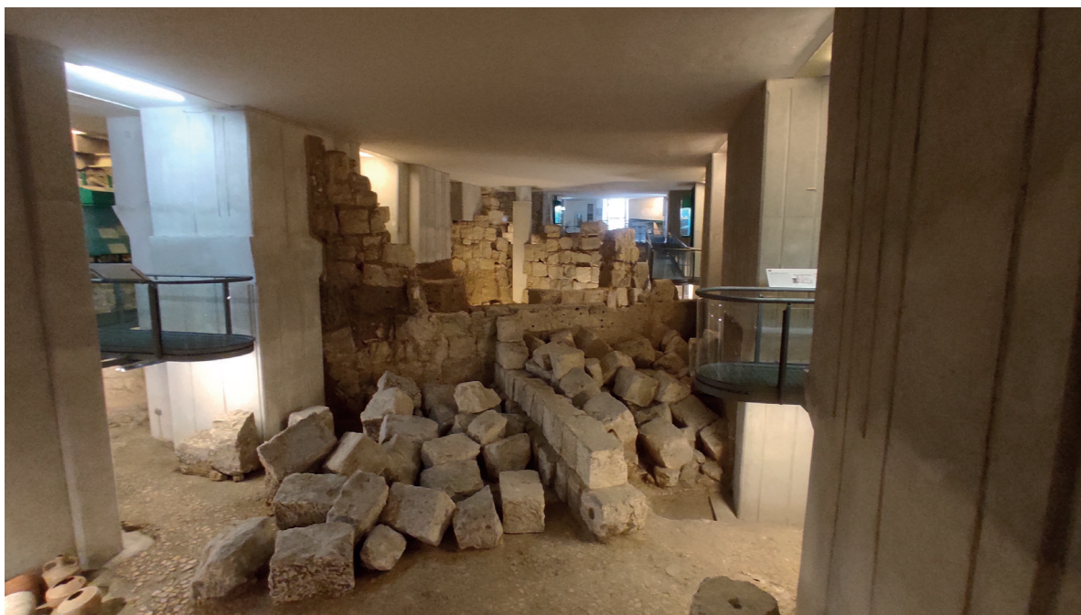
Fig. 3. Cagliari, area archeologica sotto la chiesa di S. Eulalia nel quartiere della Marina, crollo definitivo del muro di fondo del portico, mai più risollevato, ma ricoperto da un livellamento di terra (foto di Sara Tacconi).
