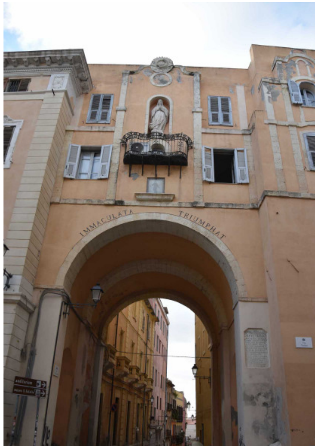
Fig. 6. Il convento osservante è suddiviso in due corpi architettonici, separati dalla strada di Santa Rosalia , attuale via Principe Amedeo, e collegati da un sovrappasso.
