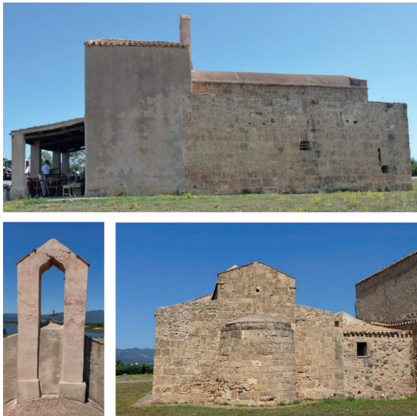
Fig. 6. NORA – In alto, prospetto sud della chiesa; in basso, a sinistra, dettaglio del campanile a vela; in basso, a destra, prospetto est (E. Pilia).
