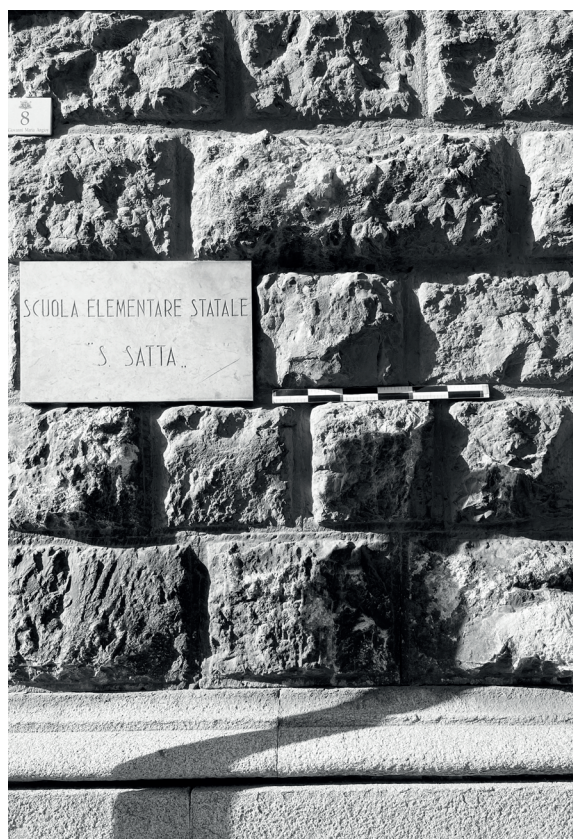
Fig. 6. CAGLIARI – Scuola Satta. Particolare del basamento bugnato con tipologie rustiche e a cuscino (foto E. Bianchi).
