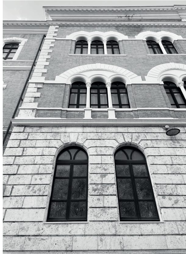
Fig. 5. CAGLIARI – Scuola Riva. Particolare del basamento bugnato in pietra di Serrenti (foto E. Bianchi).
