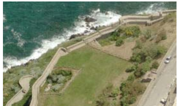
Fig. 13- Terrapieni seicenteschi emersi a seguito degli scavi archeologici nell'area degli "spalti Manganello" (RAS 2008)
