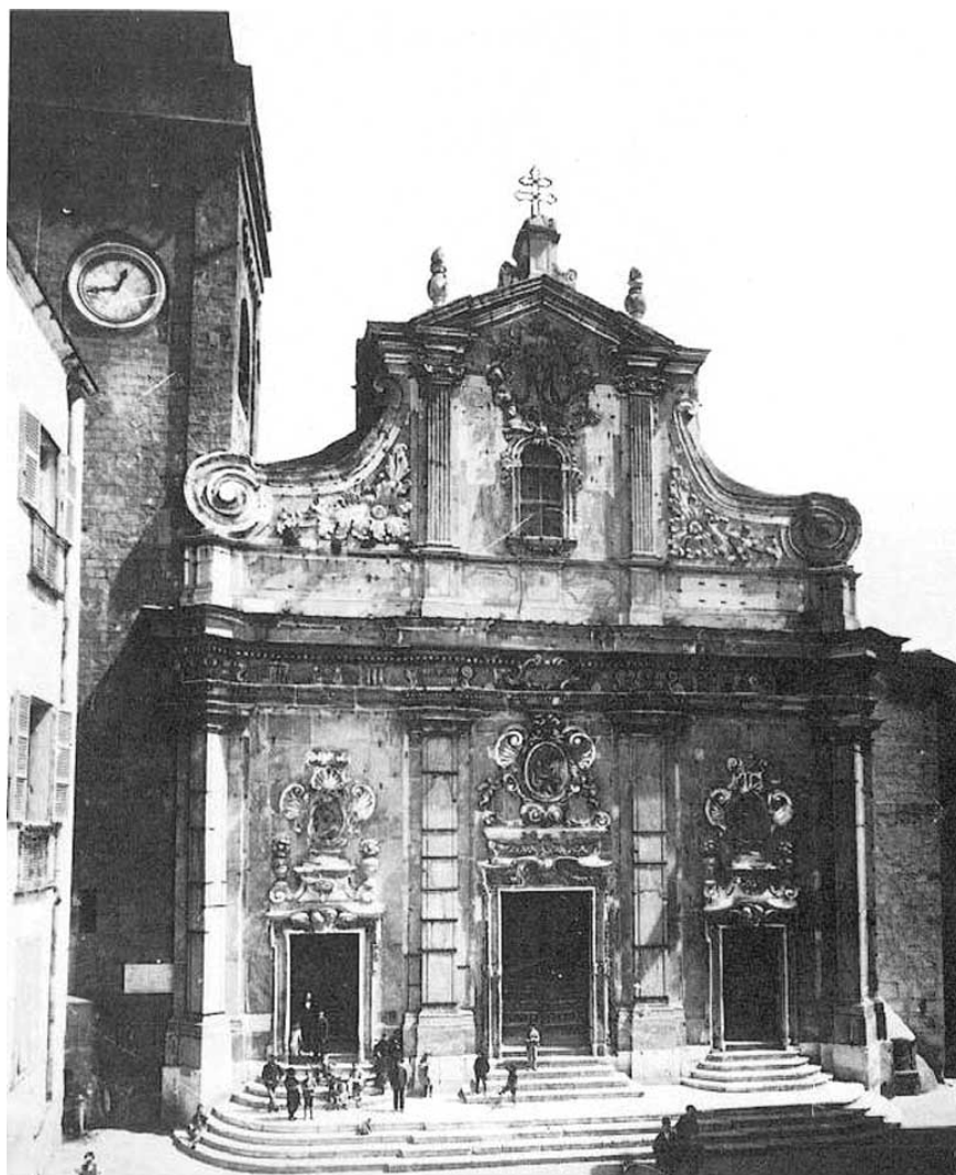
Fig. 1: Cagliari, cattedrale di Santa Maria, facciata ante 1902 (da INGEGNO 1993: 243).
