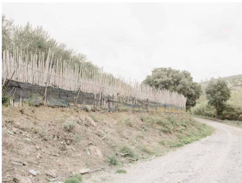
Fig.24. Sistemi di divisione della proprietà: recinzione leggera con cannicciata verticale e teli antivento.
