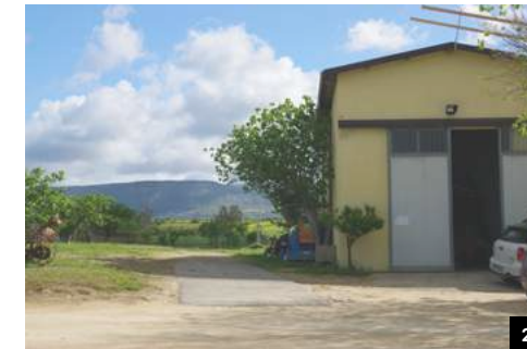
Fig.32.L'edificio agricolo di gestione
