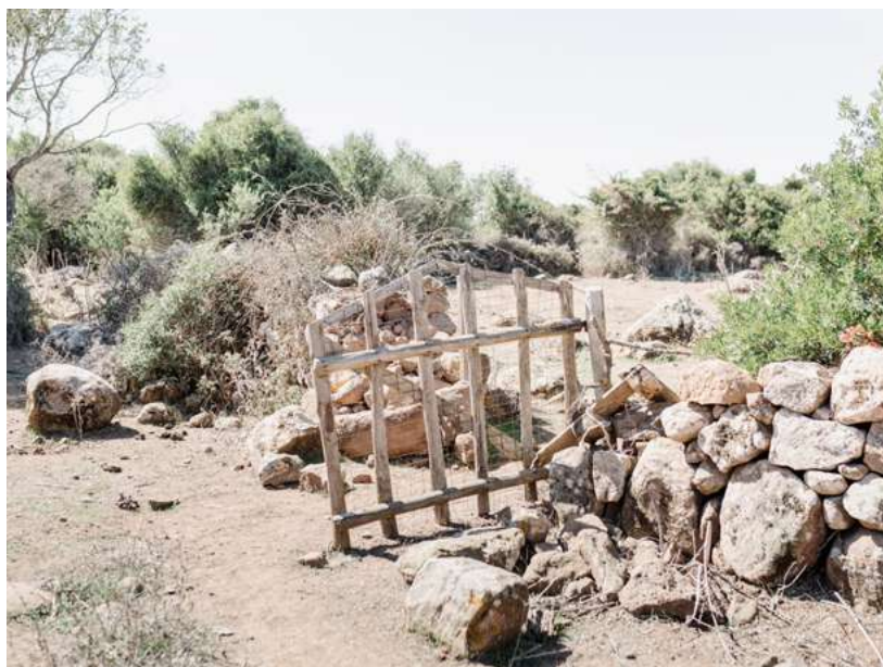
Fig.29. Soglia tradizionale realizzata con pali di legno, inserita in una muratura lapidea a secco.
