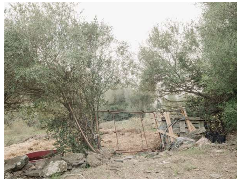
Fig.30. L'invenzione della soglia: l'uso di reti da letto è ricorrente nella realizzazione di cancelli autoconstruiti a bassissimo impatto economico e reinterpretata in chiave "prefabbricata" le logiche più proprie della tradizione locale.
