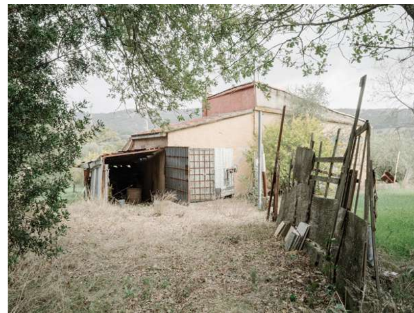
Fig.44. I dispositivi spaziali provvisori autocostruiti a presidio dell'agro, spesso, sono esito di processi di accumulazione progressiva di elementi riciclati che produce esiti critici per la qualità del paesaggio agrario.
