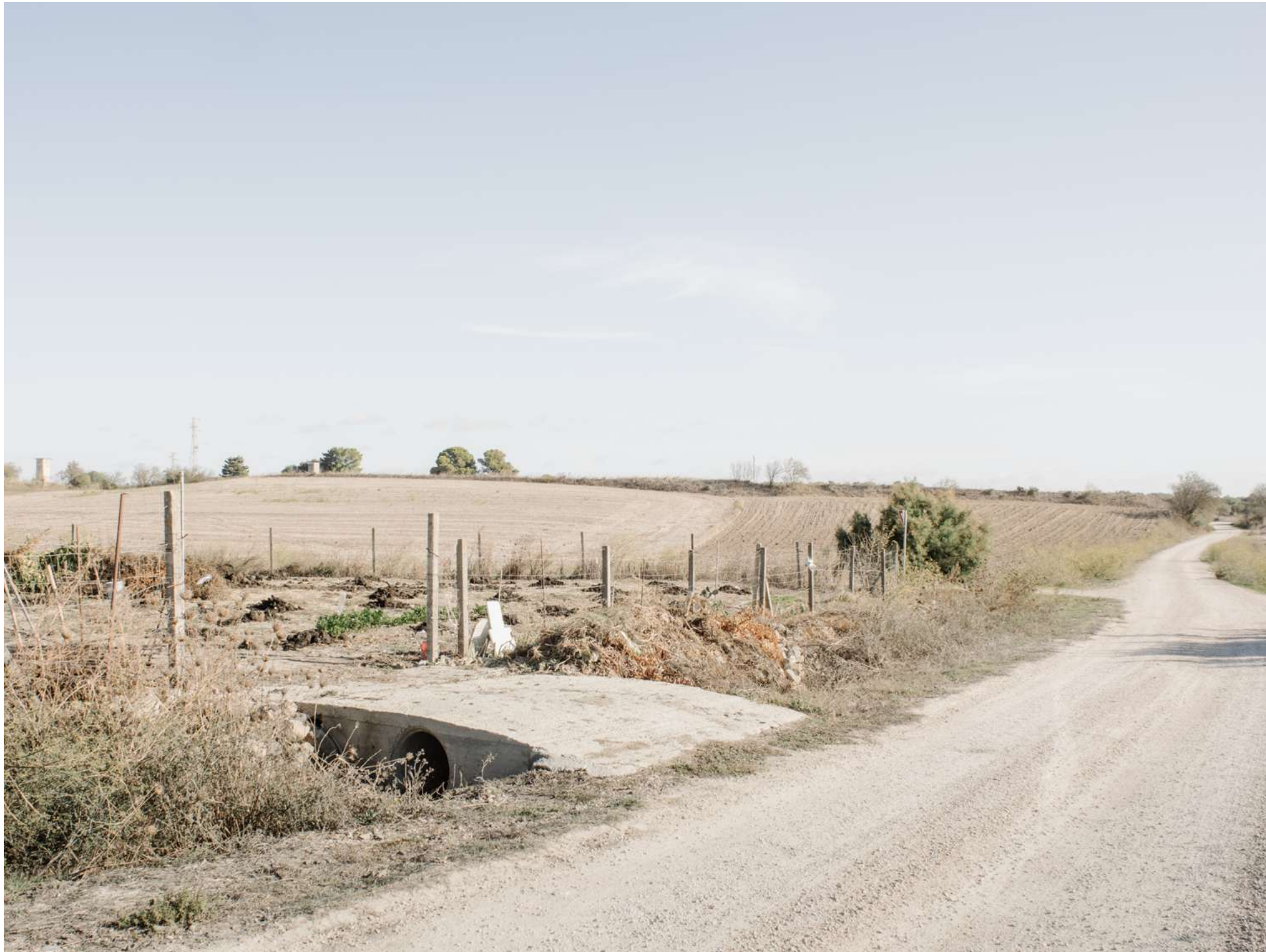
Fig.27. Soglie aperte in una recinzione metallica in filo spinato su pali prefabbricati di cls armato.
