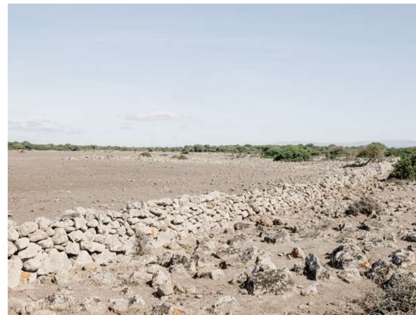
Fig.25. Sistemi di divisione della proprietà: recinzione pesante con muro lapideo a secco.
