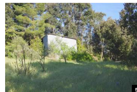
Fig.11. Capanni di servizio auto-costruiti
