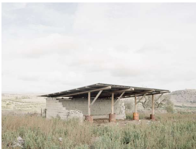
Fig.46. Dispositivi di supporto alle attività d'agro, solitamente autocostruiti, costituiscono occasione di riciclo di elementi edilizi, offrendo interpretazioni inaspettate delle forme e dei linguaggi della spontaneità.
