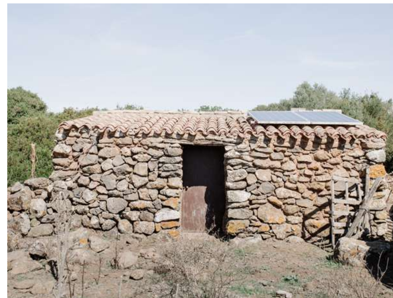
Fig.45. Commistione di tecniche appartenenti a differenti momenti storici.
