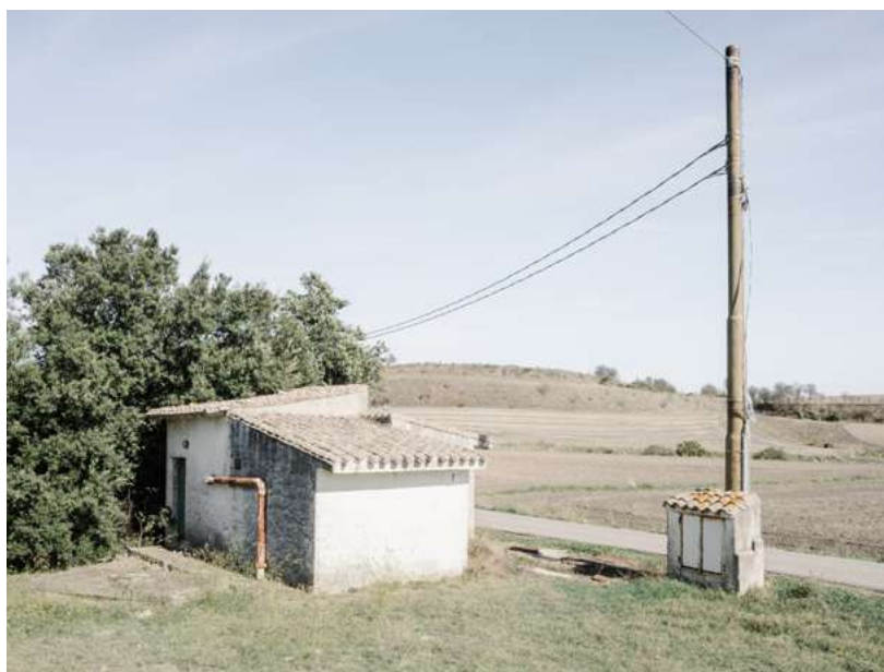
Fig.38. La presenza di piccole infrastrutture a supporto dell'agro genera punti di intensificazione nel paesaggio e lungo i percorsi.
