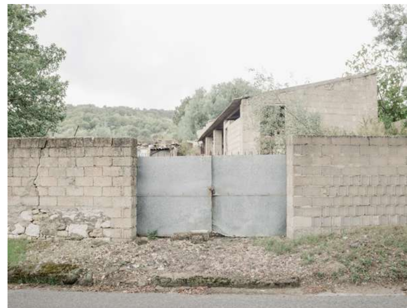
Fig.31. Soglia chiusa con cancello in lamiera metallica inserito in recinzione di blocchi in calcestruzzo.
