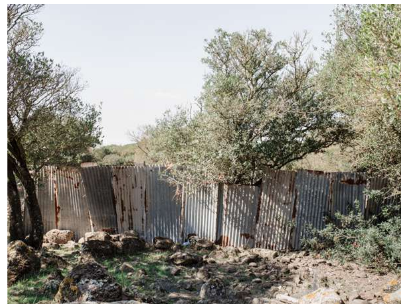
Fig.26. Sistemi di divisione della proprietà: recinzione leggera con lamiera ondulata retta da struttura lignea.
