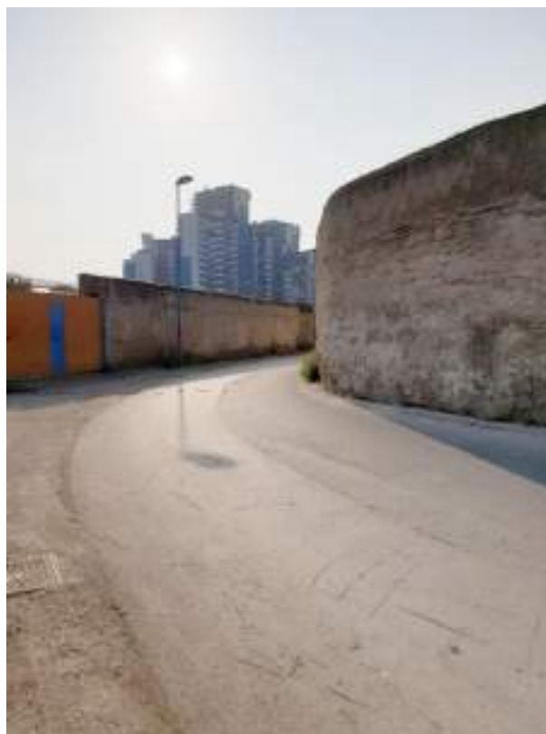
Figura 1 | La fotografia, scattata in Via Decollati, mette in evidenza la negazione del corso fluviale posto alle spalle dell'alto muro. Fonte: fotografia di Gloria Lisi, luglio 2021.
