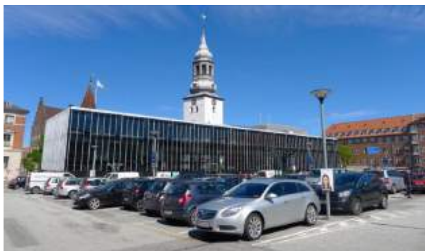
Figura 2 | Piazza Budolfi prima della trasformazione. L'edificio Budolfihus separava la chiesa dalla piazza. La piazza era occupata interamente da un parcheggio. Fonte: Aalborg Kommune, 2016.
