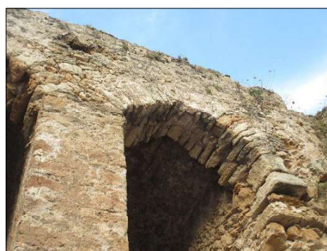
Fig. 11- Bastione della Maddalena. Dettaglio della tecnica costruttiva che prevede una connessione tra setti e archi in muratura (2016).
