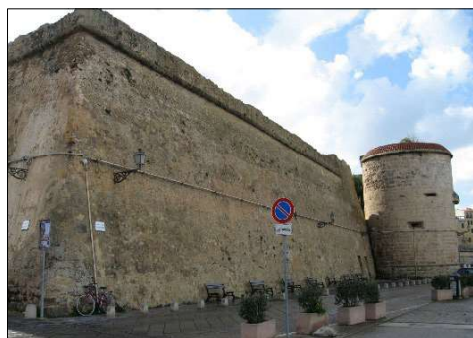
Fig. 8- Bastione della Maddalena (1552-1578) ad Alghero con torre quattrocentesca impiegata con funzione di cannoniera.
