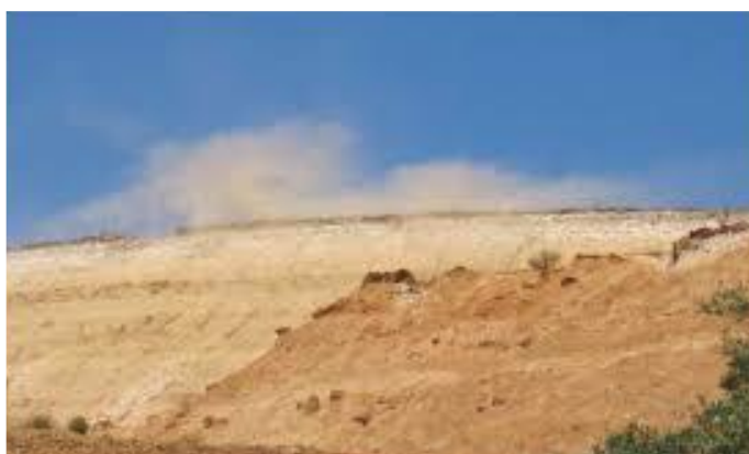
Figura 2.3. Discarica fanghi rossi a Monteponi (Italia). In foto, sono rappresentati i fini asportati dalle superfici dall'azione erosiva del vento (ISPRA, 2014).
