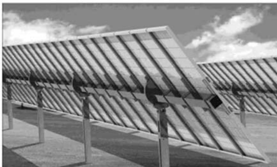
Figura 96 Tracker inseguitore mono assiale - vista laterale delle strutture di sostegno
