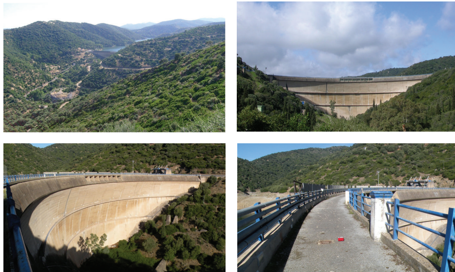
FIGURE 2: Some pictures of Punta Gennarta Arch Dam.
