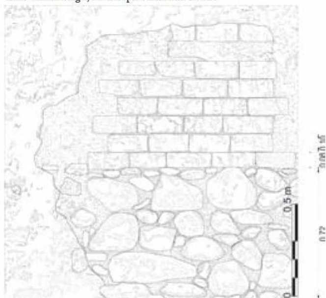
CM3. Villamassargia, via Angioi, 1. Paramento esterno
