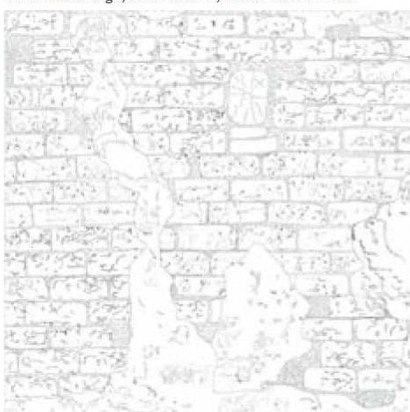
CM2. Villamassargia, via Girilli, 74-76. Paramento Esterno
