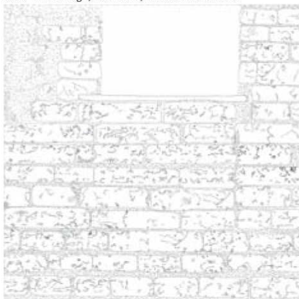
CM3. Villamassargia, via di Vittorio, 9. Paramento Esterno
