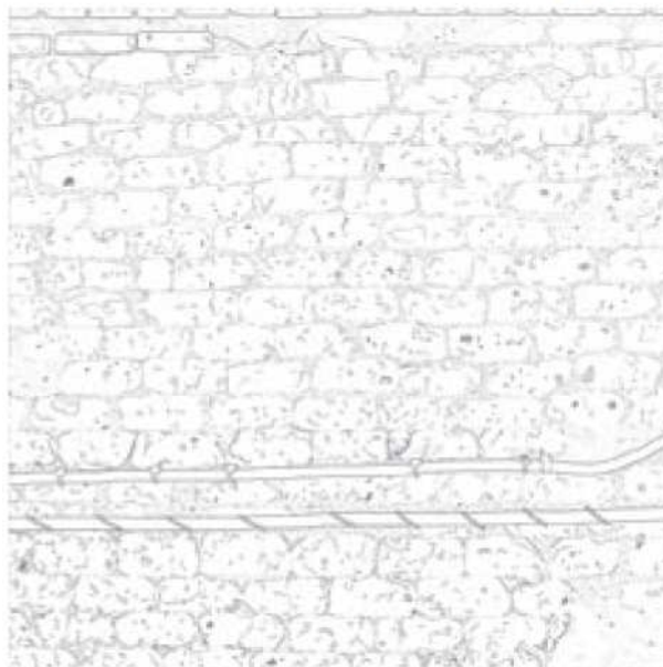
CM1. Villamassargia, via Mazzini, 18. Paramento Esterno
