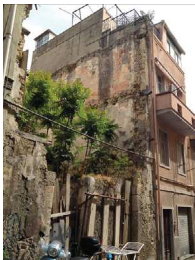
Figure 2 : Éboulement historique rue Piccioni
