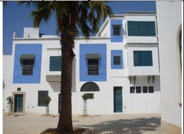
(D) Coloured amorphous PV technology in façade
