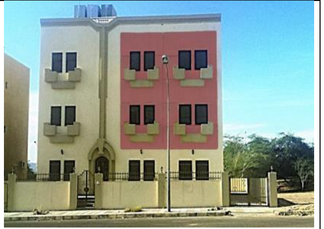
(D) Coloured amorphous PV technology in façade
