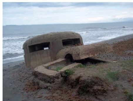
Fig. 5– Il fortino sulla spiaggia alla strada 18 Ovest. Foto C. Mura.
