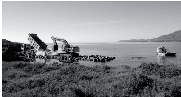
Fig. 4 - Nora, Indagini archeologiche subacquee (destra) durante i lavori di posizionamento delle barriere soffolte (sinistra) lungo la cala occidentale della penisola.
