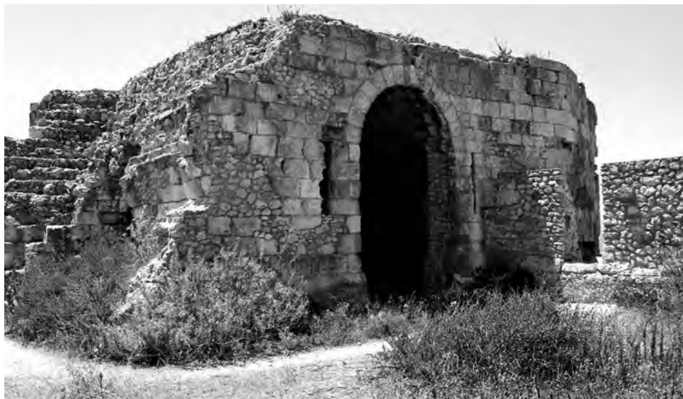
Fig. 15 Cagliari, forte di Sant'Ignazio, casamatta di ponente, esterno
