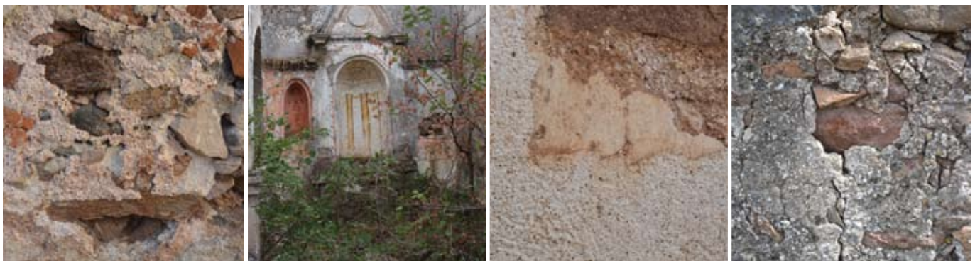
Chiesa di S. Giovanni. Particolari di tecniche di finitura ad intonaco
