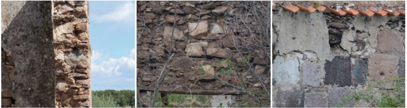
Chiesa di S. Giovanni. Particolari delle tipologie costruttive
