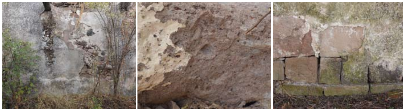
Chiesa di S. Giovanni. Particolari di alcune patologie di degrado sulle superfici lapidee ed intonaci
