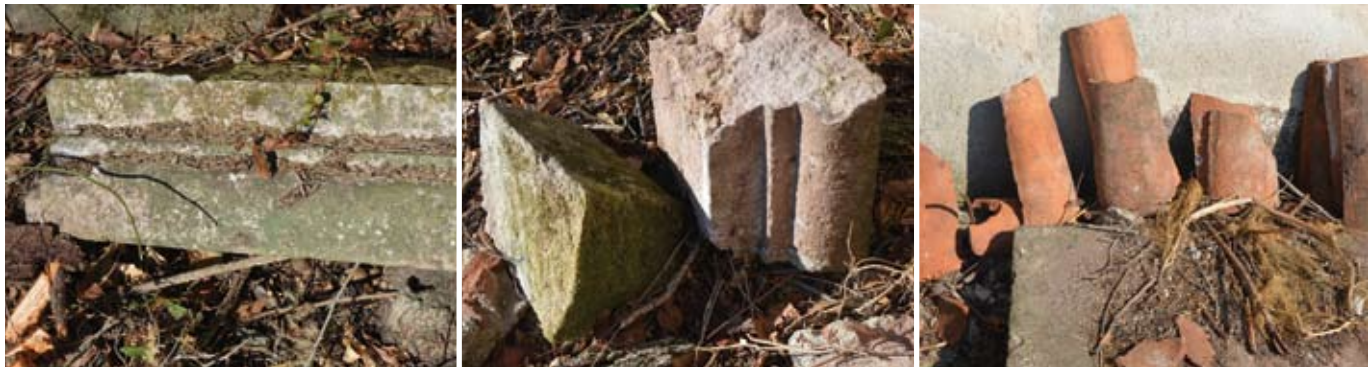
Chiesa di S. Giovanni. Particolari di elementi architettonici ancora presenti nell'area di sedime interna al rudere
