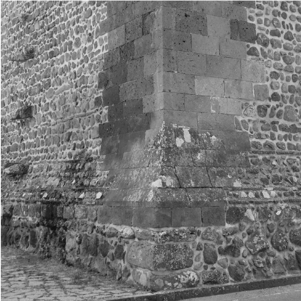
Figura 11. Ghilarza, Donjon. La fabbrica è realizzata prevalentemente con un unico litotipo, il basalto, impiegato in forme diverse: lavorato (conci squadrate), semilavorato (bozze) e non lavorato (grossi trovanti impiegati nel basamento) (foto V. Pintus 2015).
