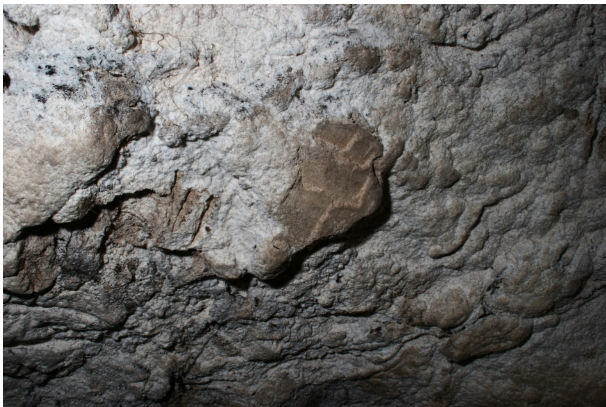
Fig. 5. Particolare di una porzione della volta con i segni della lavorazione (foto Ugo Viridis).
