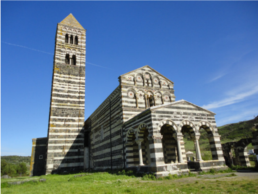
Fig. 1. Codongianos, Santissima Trinità di Saccargia, facciata (foto N. Usai).
