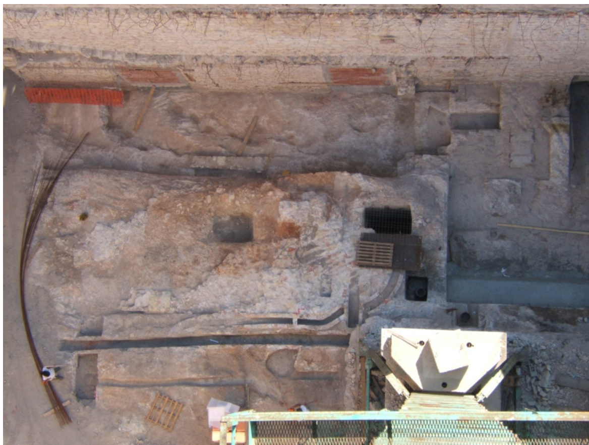
TAV. II: CAGLIARI - Teatro Massimo. 1) cortile interno del Mulino Merello (da Angius 1902); 2) Il cortile interno durante l'intervento di scavo: sono a vista le canalizzazioni del mulino (foto G. Onnis).
