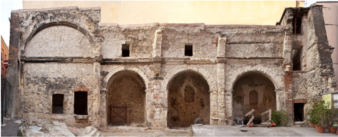
Fig. 3. Montaggio fotografico con il raddrizzamento del prospetto interno laterale destro; potrebbe diventare una loggia aperta sulla piazza di Santa Lucia al termine delle campagne di restauro e scavo archeologico. La quota della piazza dovrebbe rispettare quella del pavimento pertinente al progetto della chiesa seicentesca (foto Stefano Ferrando).
