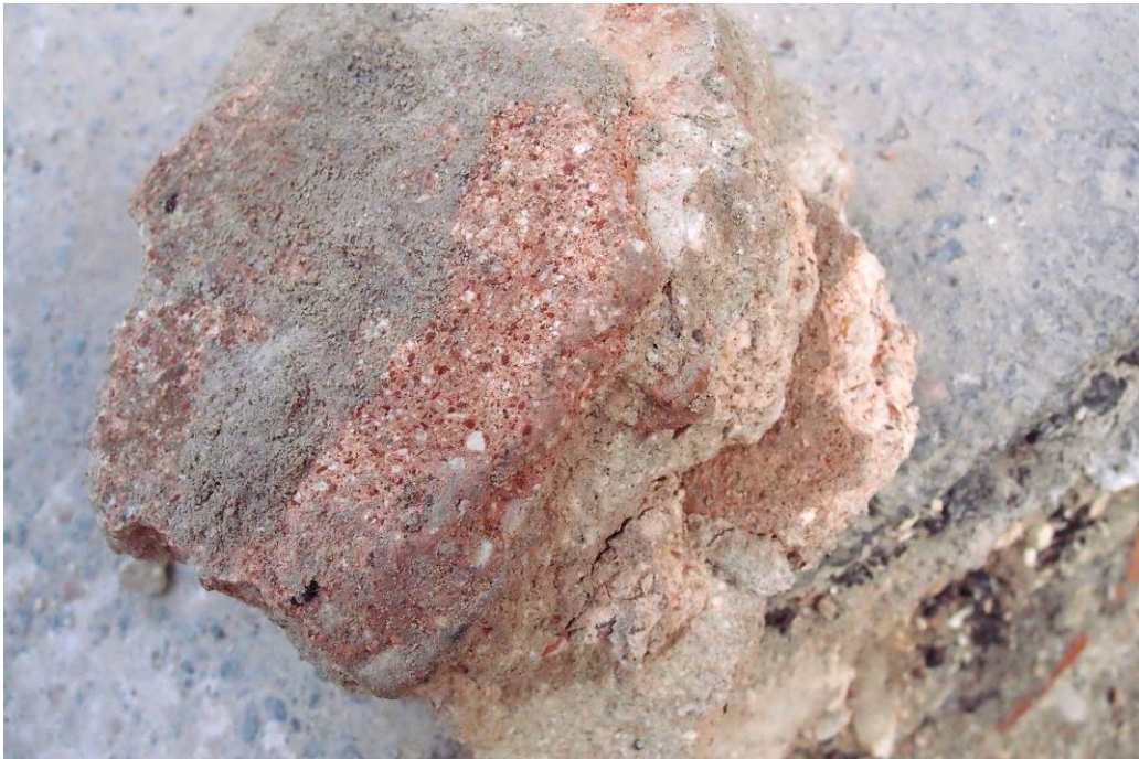
Fig. 4. Un frammento della copertura della chiesa eseguita con differenti strati sovrapposti di cocciopesto. Le strutture della chiesa demolita formano uno spesso strato sopra la originaria quota del pavimento (foto M.Cadinu).
