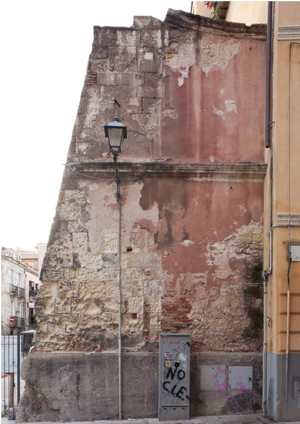
Fig. 13. L'imposta degli archi della prima e della seconda cappella di destra. È evidente alla base la parte alta circa un metro e venti rimasta per oltre 60 anni sotto l'asfalto (foto S. Ferrando).
