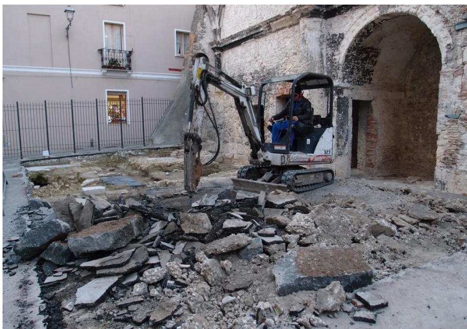
Fig. 8. Demolizione dell'asfalto e dello spesso strato in calcestruzzo steso sul sedime del monumento (foto M.Cadinu).
