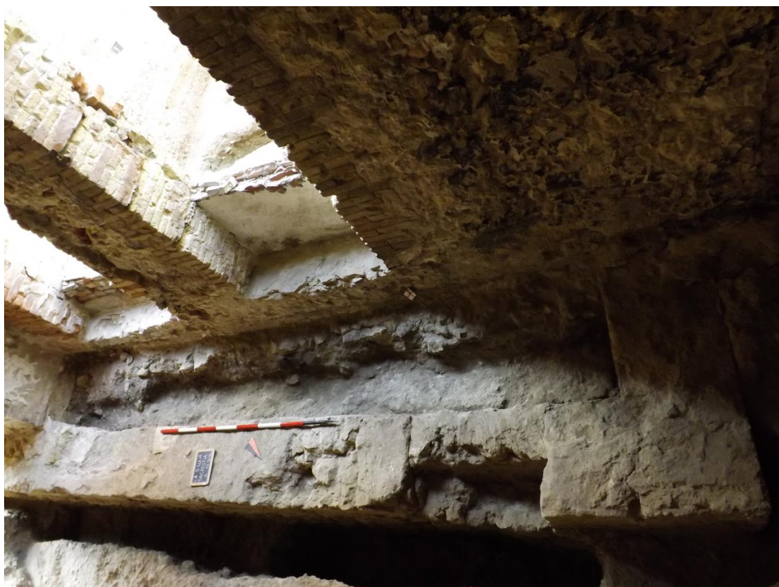
Fig. 32. Sacrestia, strutture murarie (USSMM 180, 170): l'angolo creato con il braccio a nord di cui è visibile una piccola porzione fa presumere la sua estensione nell'area presbiteriale.
