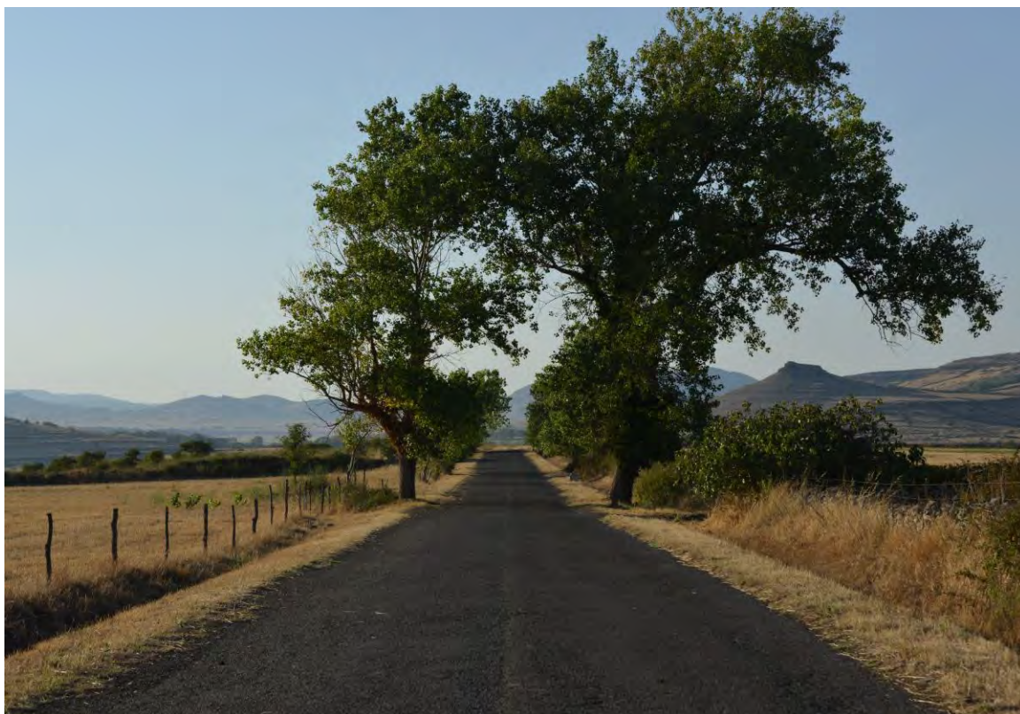
4. Uno dei tratti della Strada Reale Carlo Felice ancora esistenti tra Bonorva e Giave. Oltre alla superficie bitumata si mantiene inalterata la sezione stradale originale e l'alberatura ai lati: caratteristiche che rendono queste porzioni di tracciato superstiti luoghi dall'alto valore paesaggistico (foto dell'autore)
